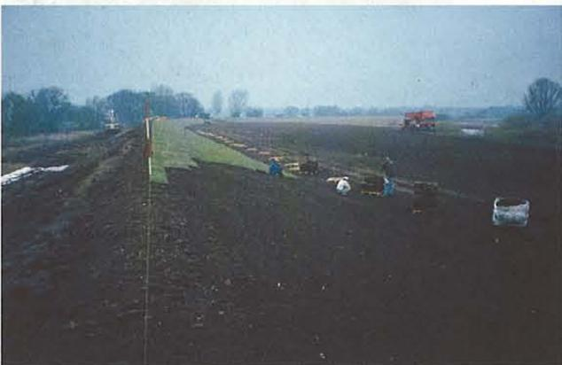
Abb. 5-10: Wasserseitiger Erosionsschutz mit Fertiggrasematten, kurz vor der Fertigstellung, Deich-km 70,4 (Hohenwutzen)
