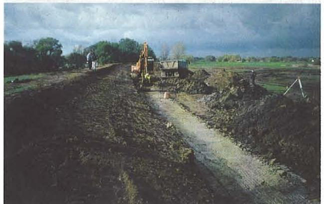
Abb. 5-8: Einbau einer Dichtungsschürze aus Ton, Deich-km 70,6 (Hohenwutzen)
