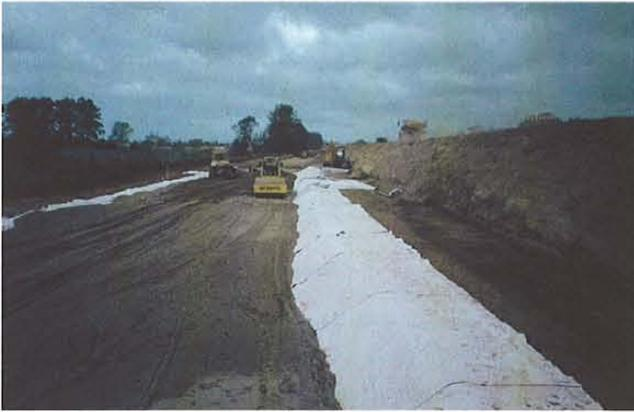
Abb. 5-9: Einbau der Filterkiese, Deich-km 61 (Zollbrücke). Aufgrund der inhomogenen Untergrundverhältnisse und Deichbaustoffe sind zusätzlich geotextile Filter angeordnet worden, die Kontakterosionen zwischen den unterschiedlichen Erdstoffen verhindern
