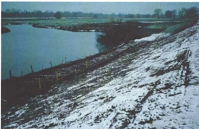
Abb. 5-5: Durch eine Vorschüttung mit bindigen Materialien „gedichteter“ Kolk, Reitwein Deich-km 4,7. Als Initialsicherung diente eine Faschinenlage mit dazwischengesetzten Weidensteckhölzern. Bäume und Sträucher, die in diesem Abstand vom Deichfuß aufwachsen, stellen keine Gefahr mehr für die Standsicherheit des Deiches und einen guten Schutz gegen Eisgang dar.
