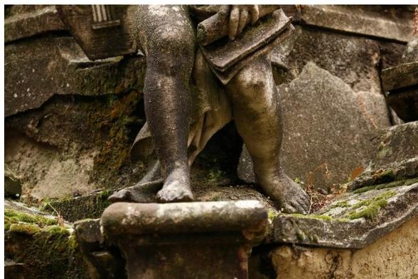
Fig. 63. Pérdida volumétrica en el basamento de la columna donde se asientan las cuatro figuras alegóricas.
