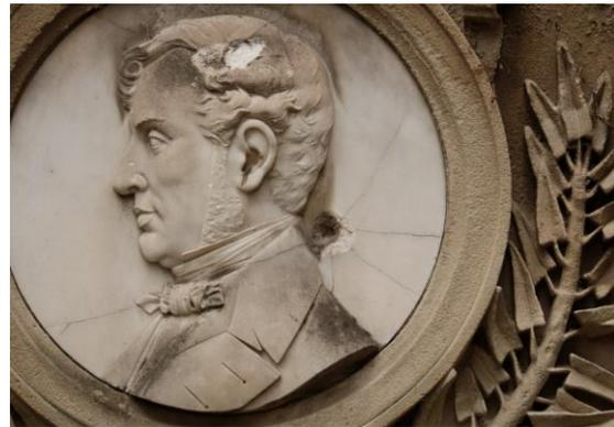
Fig. 44. Fisuración radial por el impacto de una bala
