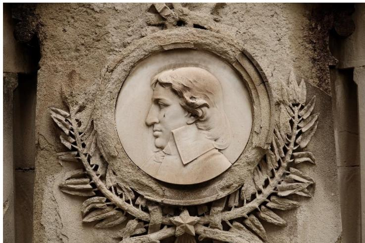
Fig. 46. Arenización y desmenuzamiento
