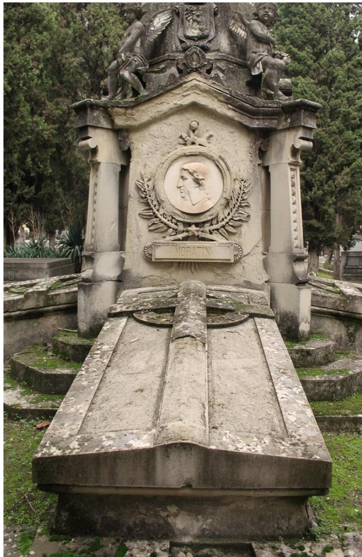
Fig. 49. Sepulcro de Moratín afectado por desprendimientos y disgregación
