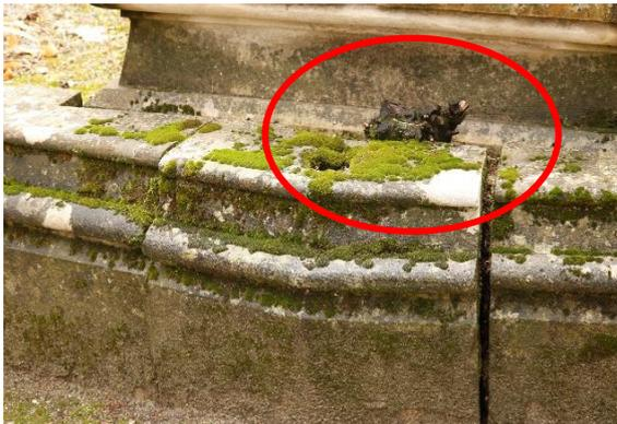
Fig. 43. Pérdida de mortero entre las juntas y desplazamiento de bloque de piedra por el crecimiento de una raíz
