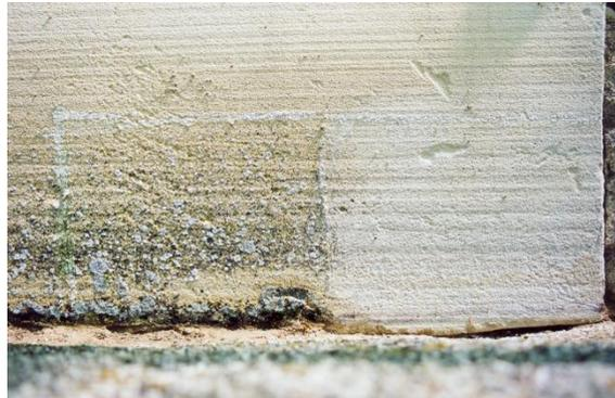
Fig. 56. Ejemplo de limpieza mecánica mediante cepillado en seco de patina biológica. Fuente M. Galán Caballero
