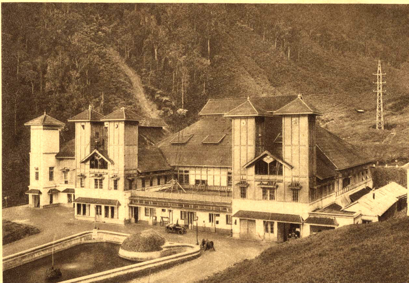
4. Gebouw van het station Malabar.
