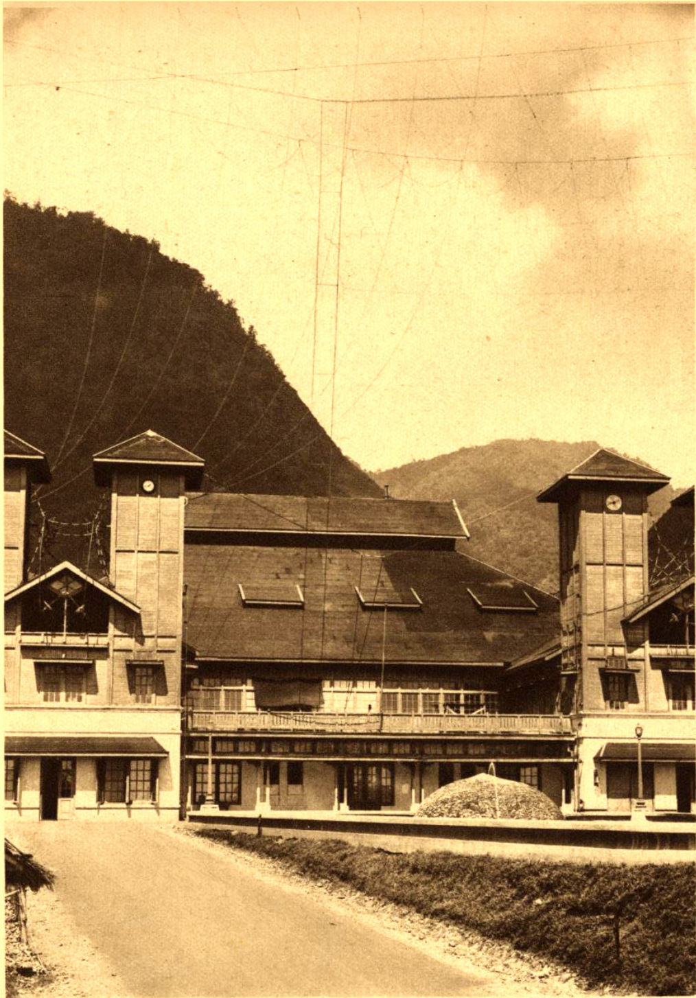
5. Voorgevel gebouw Malabar met gezicht op antennes.
