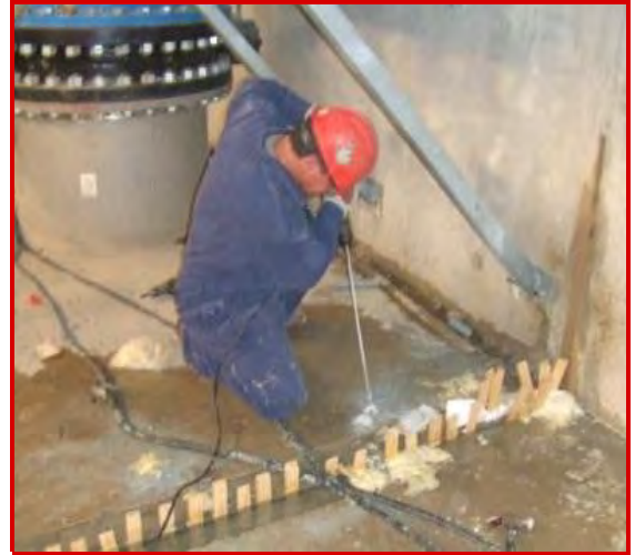
Les fissures qui fuient sont réparées en permanence à l'aide de la résine 'MME FLEXIBLE RESIN'.
