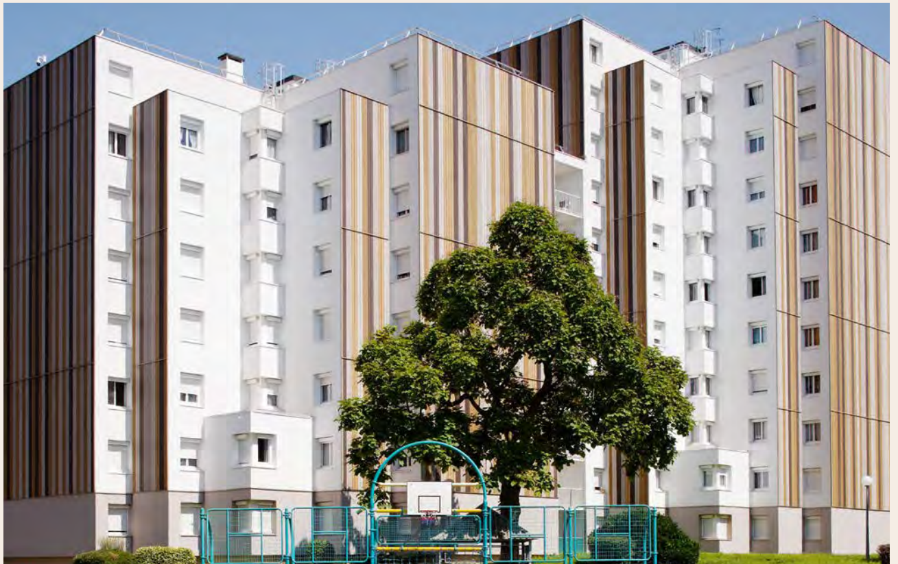
Mehrfamilienhaus - Maisons Alfort (94) - COVER 6 & 14 - Farbtöne Sand & Sun & Earth • Architekten: Nicolas Fritz / Ville de Maisons Alfort
