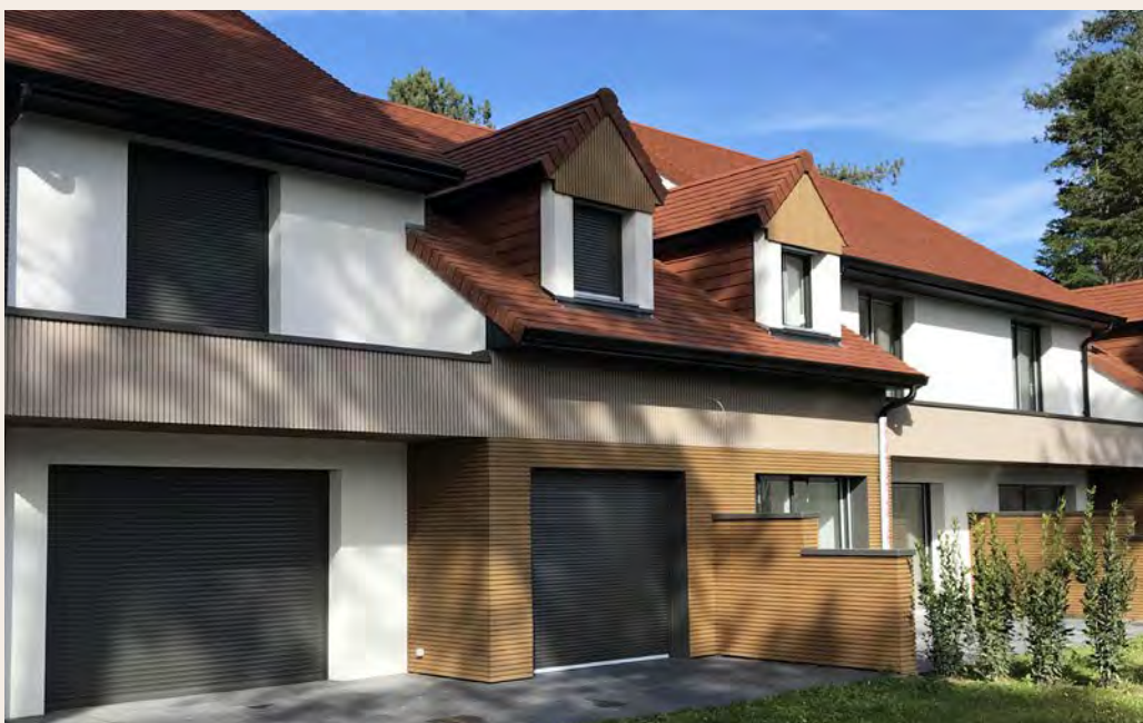
Einfamilienhaus - Hazebrouck (59) - SMART 4 - Farbtöne Sand & Sun • Architekt: REMA CONSTRUCTION
