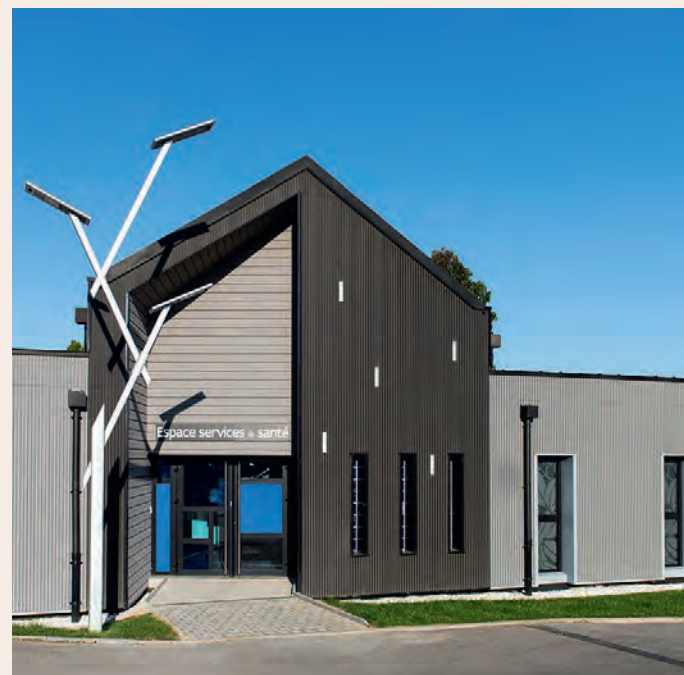
Pflegeheim - Ducey (50) - CLAD 4 & 14 - Farbtöne Night & Ocean Architekt: Michel Gourion
