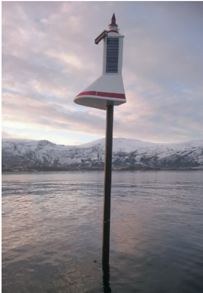
Fig.2 HIB, Lanterne på stang med indirekte belysning på trekant
