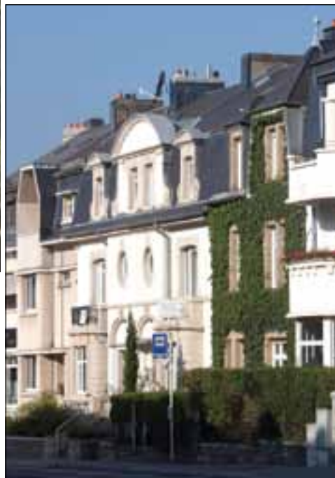
Avenue du X Septembre
