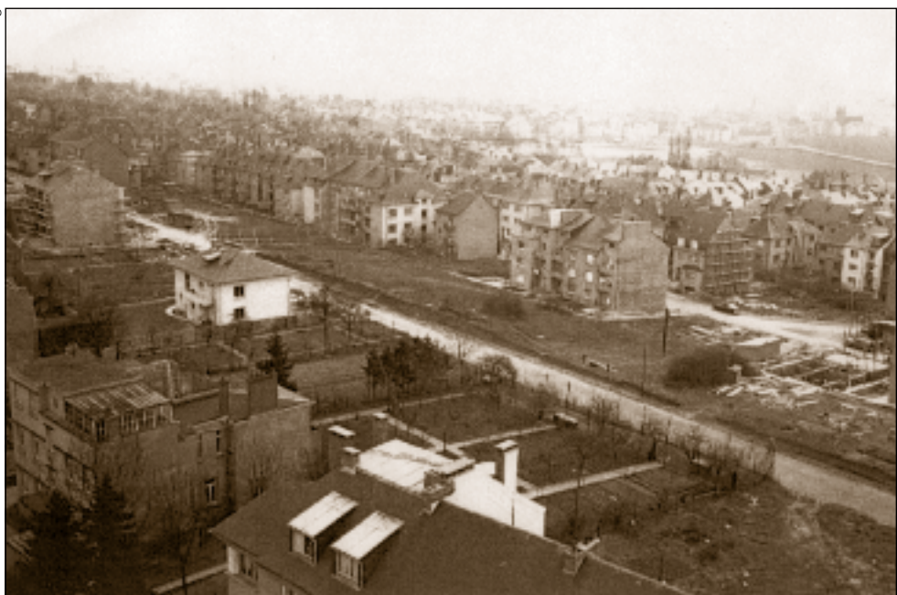
Die Rue Charles Arendt vom Kirchturm aus gesehen (um 1954)
