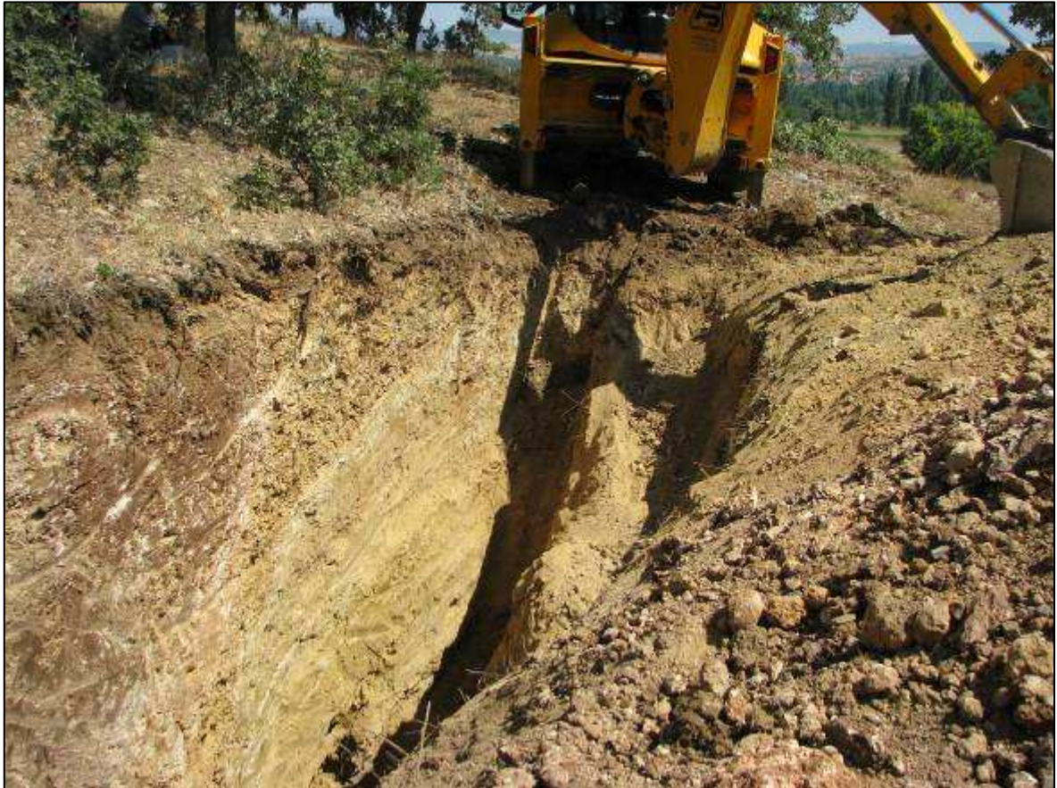
Şekil 33. Kuzeyden güneye 2 (H2) nolu hendek yerinin yakından görünümü.
