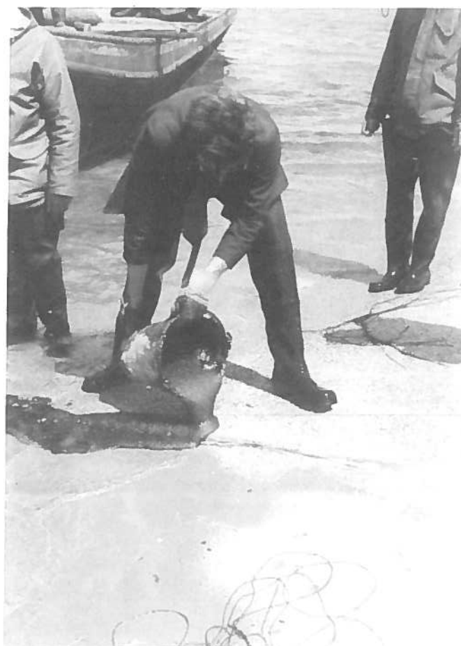
6. Vullen van de naad tussen de matten met gietasfalt
