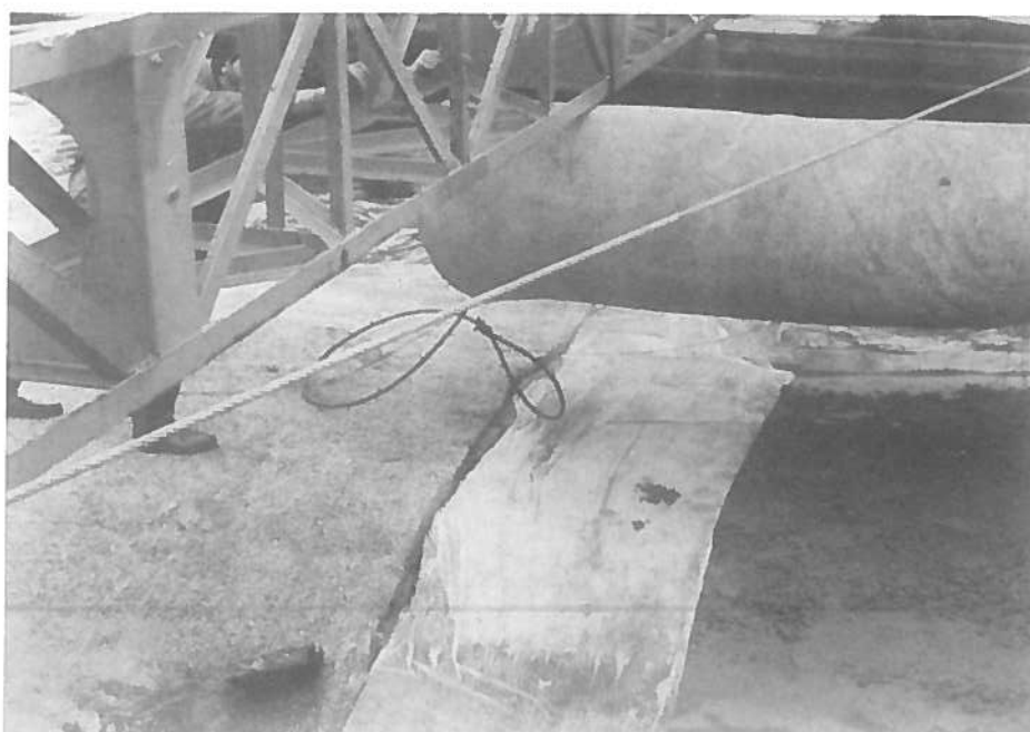
5. De nieuwe mat boven zijn plaats. Het nylondoek onder de te maken las is duidelijk zichtbaar
