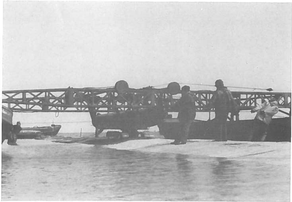
3. De mat wordt boven zijn plaats gevaren
