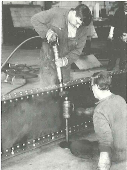
1. Het klinken van één van de hoofdliggers van de brug bij Machinefabriek P.M. Duyvis. (fotoarchief NBS)
