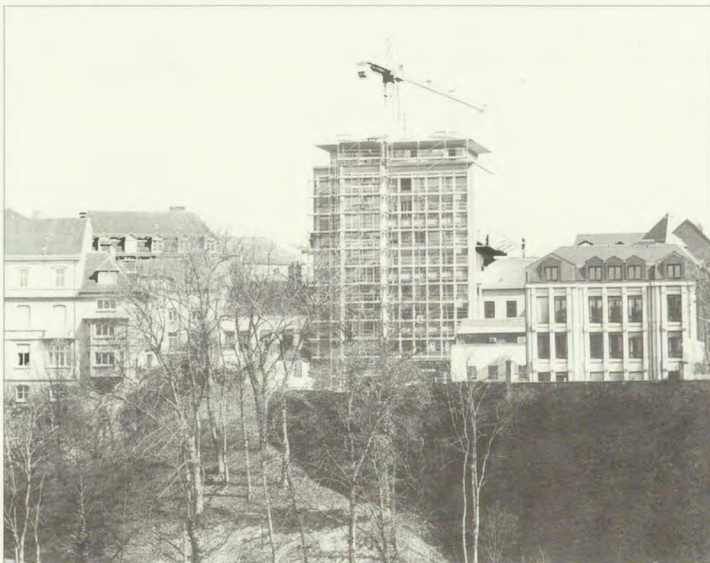
Der Abriß der „Bâloise“ hat begonnen
