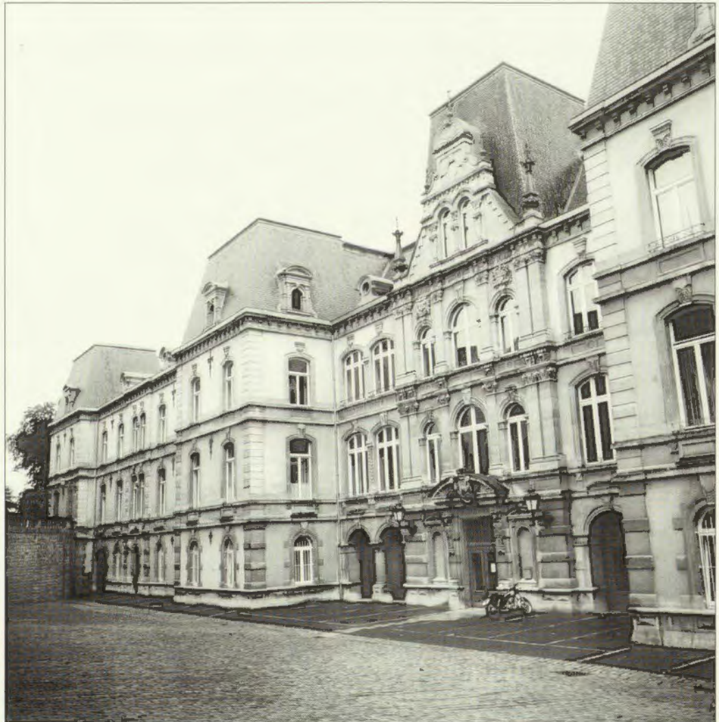
Nordfassade im Neo- Renaissance- Stil von Charles Arendt
