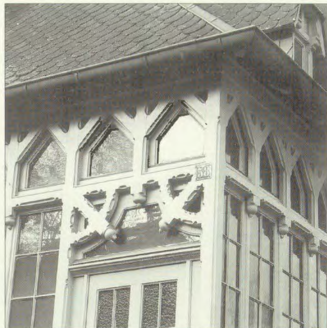
Sorgfältig gearbeitete Holzkonstruktion der Eingangsloggia
