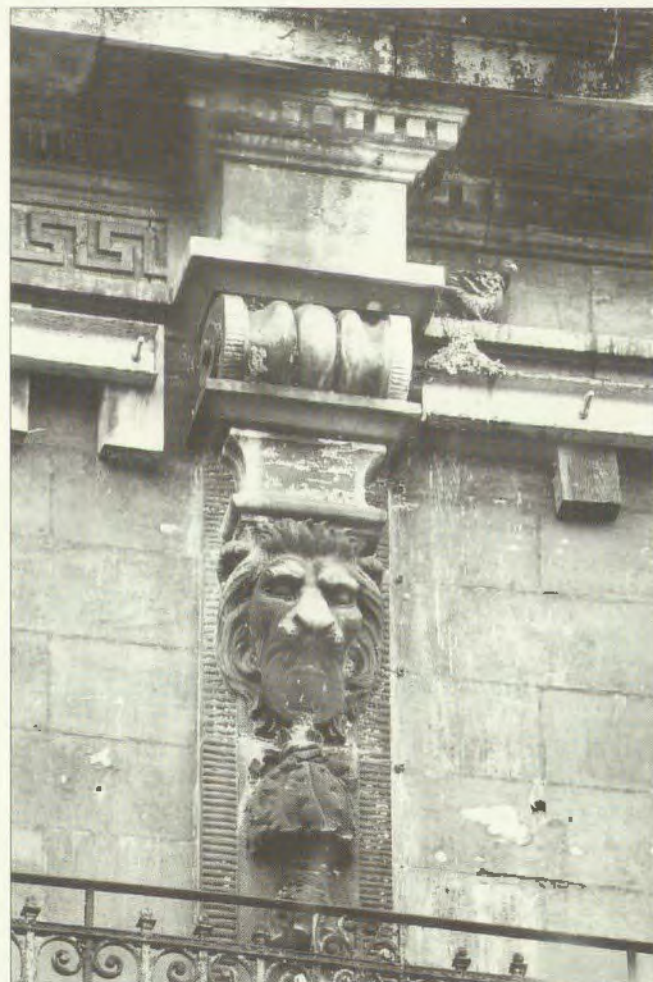
Fassadendetail des Devas-Kluge-Hauses
