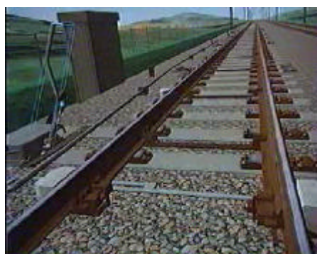
11. Enfin il doit vérifier si la lame de l'aiguille a bougé.
