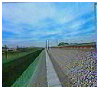
8. Il doit se déplacer le long des voies et trouver l'aiguillage qui lui a été désigné.
