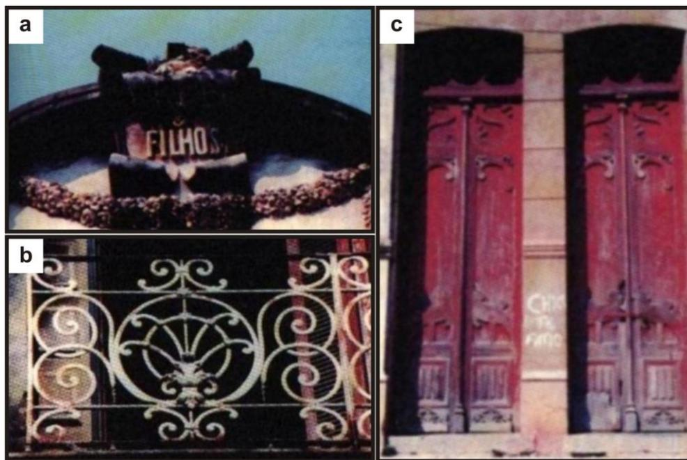
**FIGURA 5** - Algumas riquezas nas edificações do Casario do Porto que exigem medidas urgentes para não desaparecerem completamente: a) Casa Vasquez com águia já caída; b) grade de ferro em corrosão; c) portas descuidadas e pichadas.
