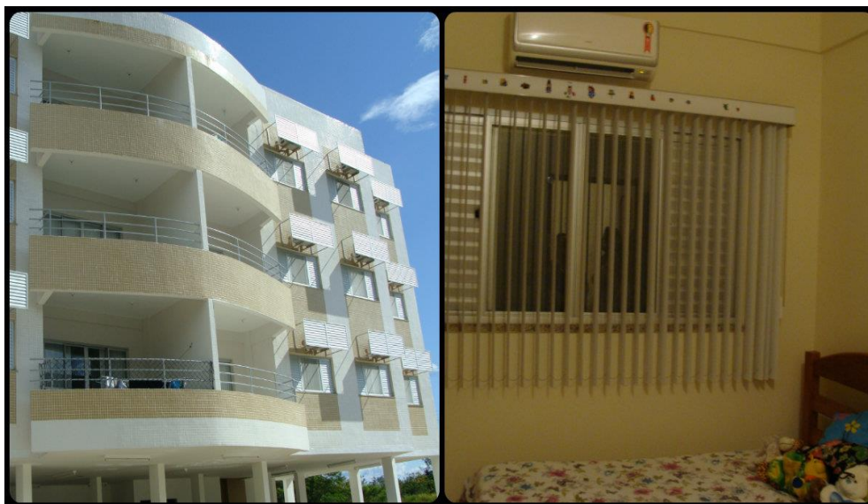
Figura 4 - Edifício militar em SGC para famílias de subtenentes e sargentos. Fachada do prédio e um dormitório. Autora: Cristina Silva.
