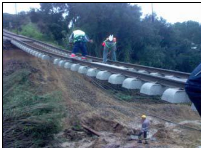
Figura 1.5 - Acção de conservação da via-férrea, devido há à instabilização de vertentes (Fonte: REFER).
