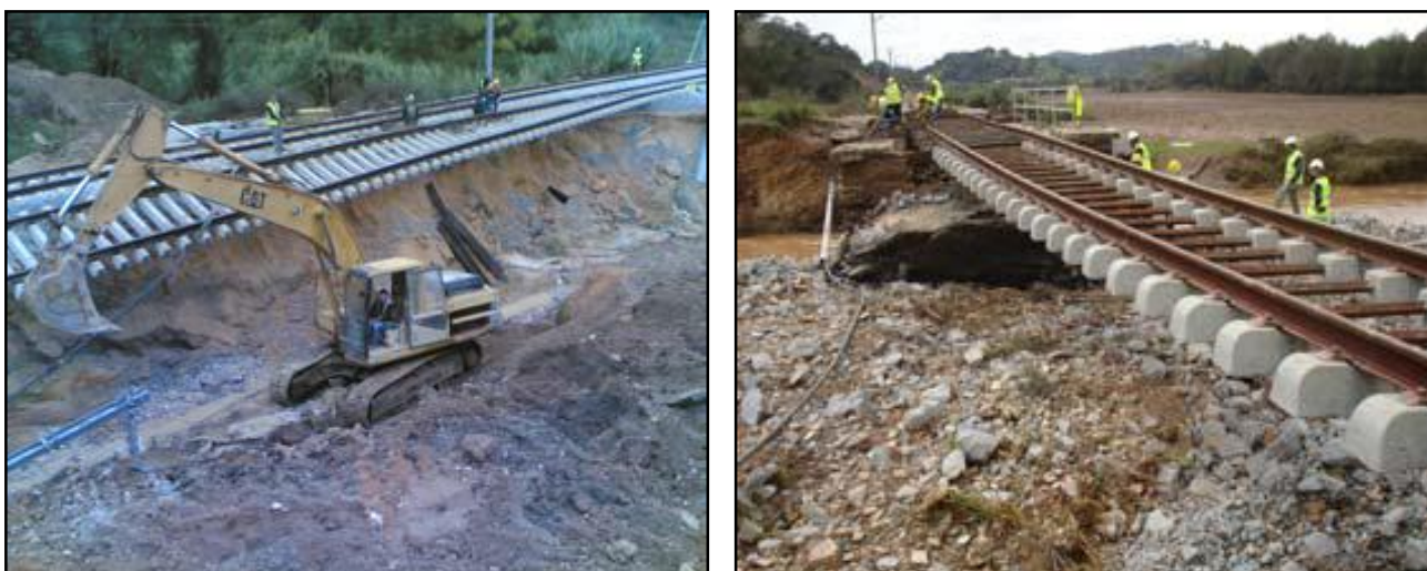
Figuras 1.3 e 1.4 - Acções de conservação da via-férrea, devido à instabilização de taludes. (Fonte: REFER).
