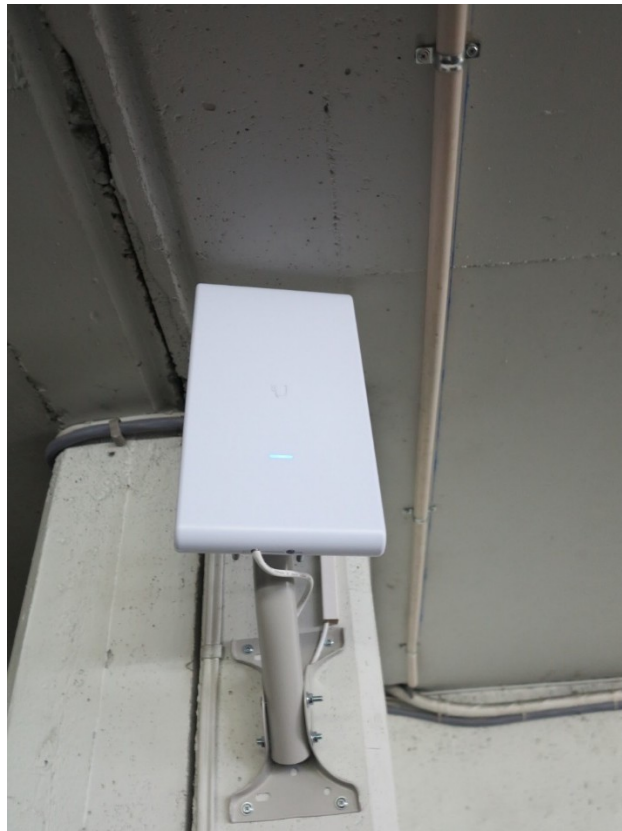
Bild 3-8 Ett trådlöst nätverk säkerställer att elbilsladdningen kan styras av det dynamiska laddsystemet.
