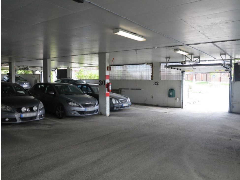
Bild 3-2 Bottenvåningen i det gemensamma garaget har två portar för in- och utkörning.
