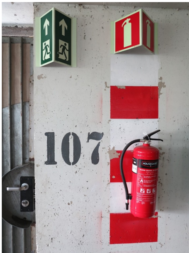
Bild 3-9 Efter en tidigare brandrådgivning blev utrymningsvägar och brandsläckare tydligare markerade. Det finns fyra handbrandsläckare på varje våning.
