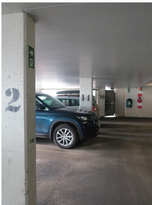
Bild 3-10 Utrymningsvägarna är tydligt markerade på flera ställen i garaget.
