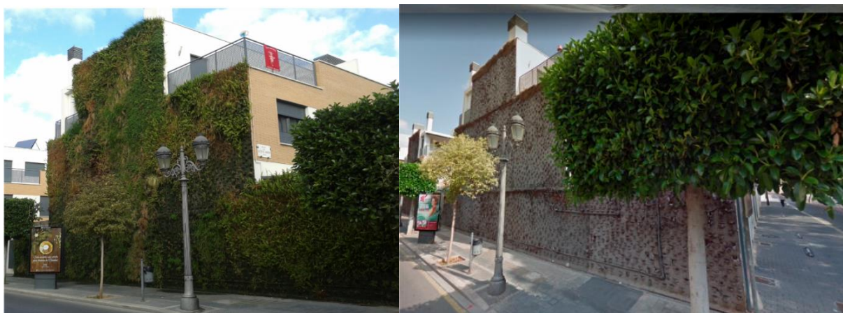
Ilustración 8. Ejemplo de abandono de un jardín vertical con sistema geotextil (Fte: Google maps)
