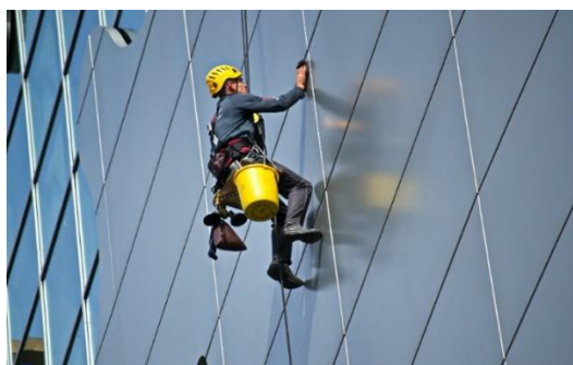
Ilustración 14. Ejemplo de trabajos en altura en fachadas
