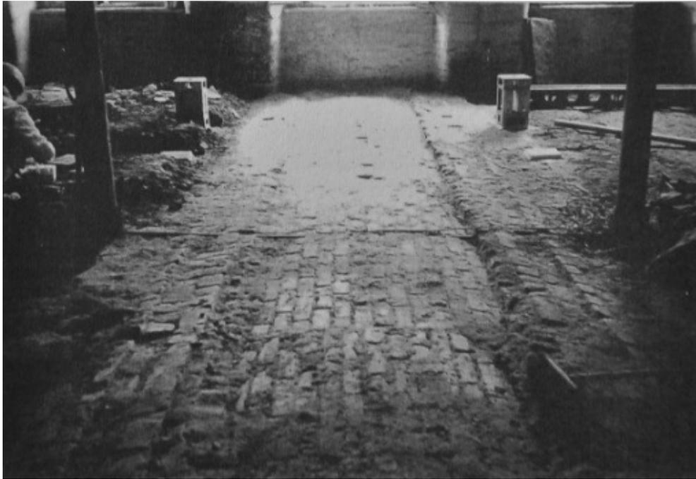
*Figura 161. Havelock Cotton Mill, Mánchester, 1845. Estructura metálica: columnas y vigas de hierro fundido atadas entre ellos con barras de hierro forjado entre las bóvedas de ladrillo, las cuales tenían un relleno de ceniza para formar los forjados (Swalles, 1998).*
