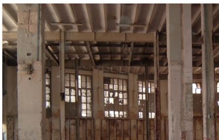
*Figura 263. Fábrica de Carbonell. Se distinguen en el interior los forjados de bóvedas apoyando en las viguetas metálicas, así como las vigas de acero.*
