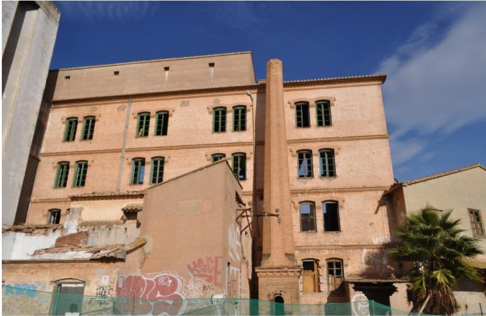
*Figura 284. Fachada lateral. Orientación sureste. Se constata en la imagen que su accionamiento fue mecánico por medio de máquina de vapor y su posterior acometida eléctrica trifásica. Aparentemente, su exterior demuestra un buen estado de conservación (Fotografía propia. Diciembre 2012).*
