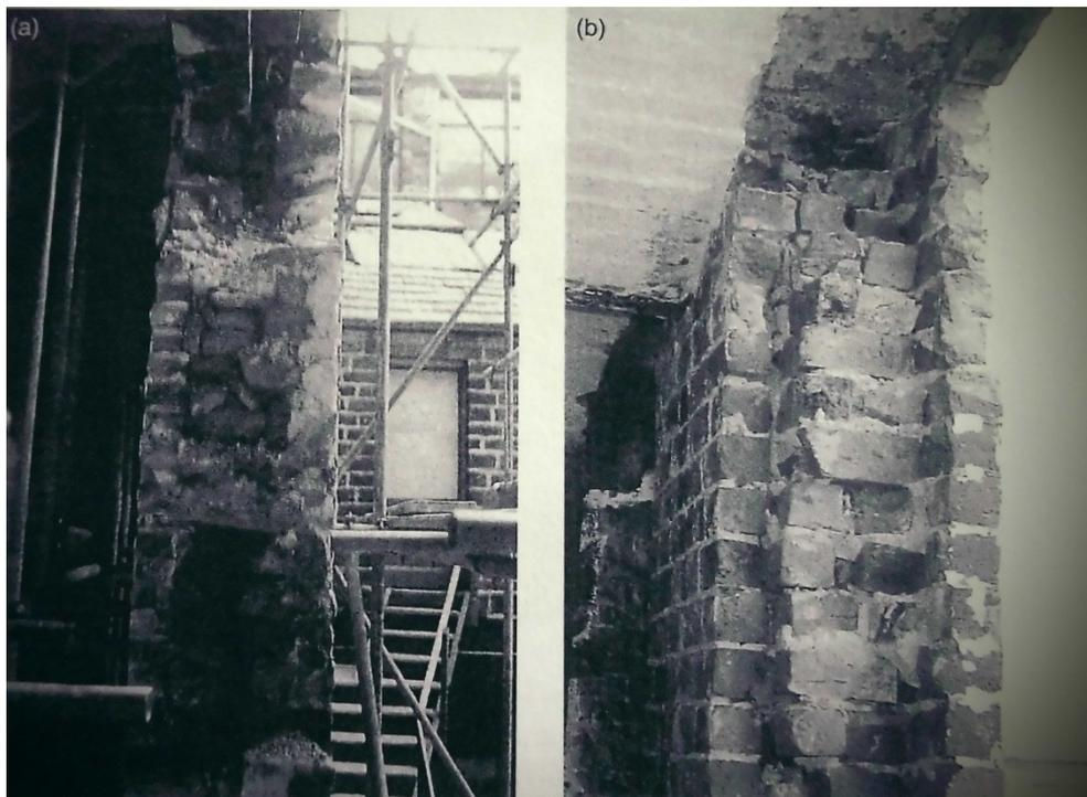
Figura 167. A la izquierda, Greenup's Worsted Mill, 1791. Se trata de un “mill” de 5 alturas. Se distinguen las 3 capas mencionadas, de la que el relleno es escombros. A la derecha, una sección de un muro portante posterior al anterior. La capa intermedia está realizada con fábrica de ladrillo (Swales, 1998).
