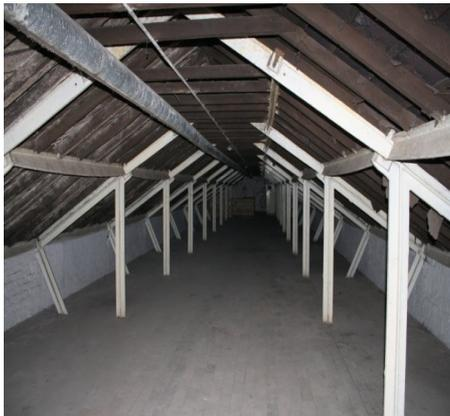
Figura 60. Vista interior de la cubierta, hasta la que llegaban los pilares metálicos de sección cruciforme.
