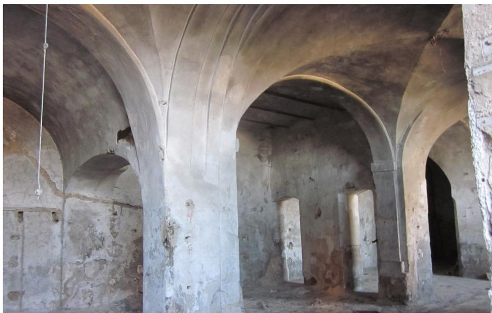
*Figura 229. El batán de Brutinel o Molino viejo (construido entre 1760 y 1774), en el cauce del río Barxell. Como se ve, el sistema constructivo de formación del forjado de planta baja no coincide con el de los "mill buildings" ingleses. Aquí se trata de bóvedas de rasilla, que en este caso concreto se han enlucido con mortero de cal (Fotografía propia. Julio 2012).*
