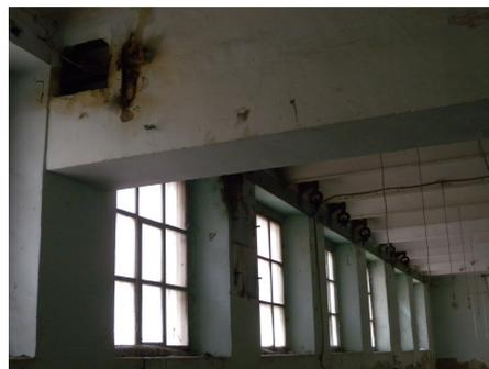
*Figura 306. Interior del edificio señalado, planta baja, donde se aprecian perfectamente los soportes de los ejes giratorios que accionaban las máquinas.*
