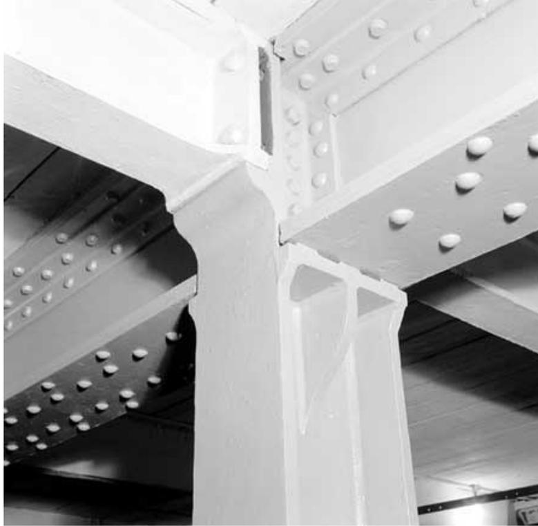
Figura 99. Astillero de Sheerness. Detalle de la unión en la estructura metálica interior, toda ella roblonada (<http://www.viewfinder.english-heritage.org.uk>).
