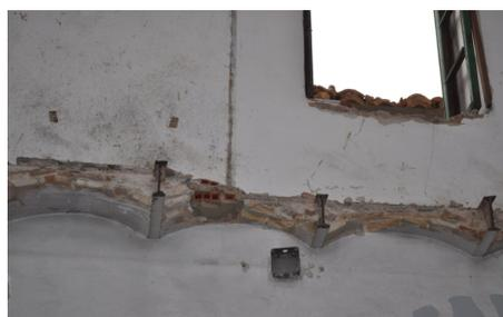
Figura 287. Detalle de la estructura del forjado, con viguetas de hierro con perfil en doble T y bóvedas de ladrillo demolidas.
