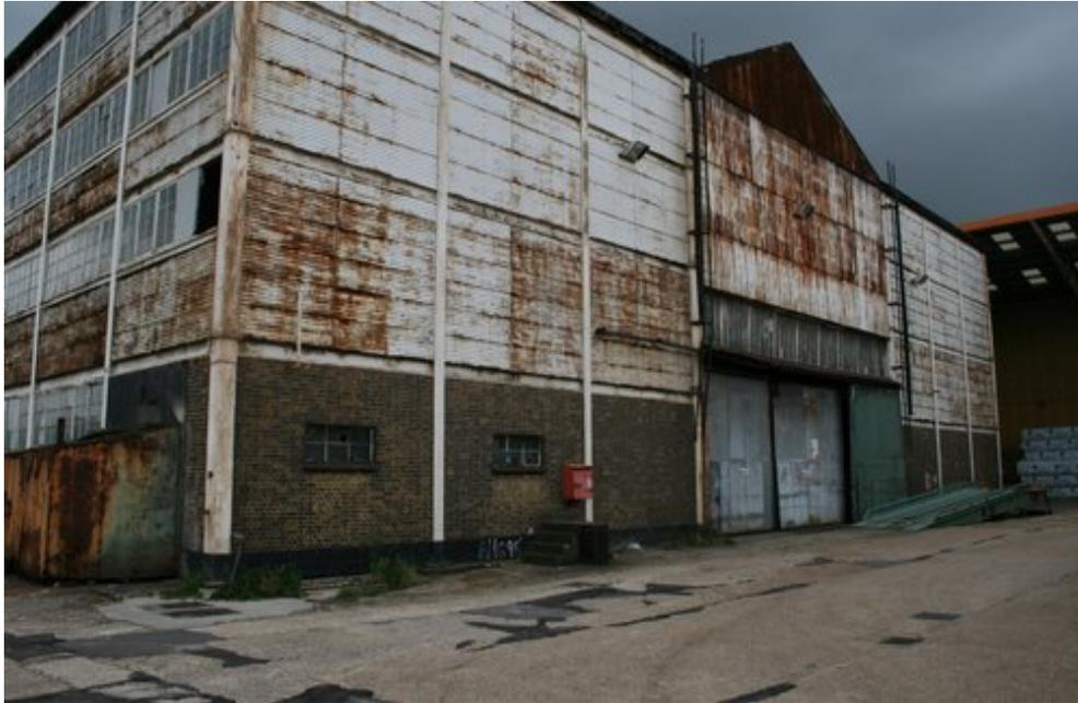
*Figura 95. Astillero de Sheerness, Inglaterra, 1858. Fachada principal mayoritariamente metálica. Con este edificio se constata que el hierro ya ha llegado a la fachada (<http://www.panoramio.com/photo/27899360>).*
