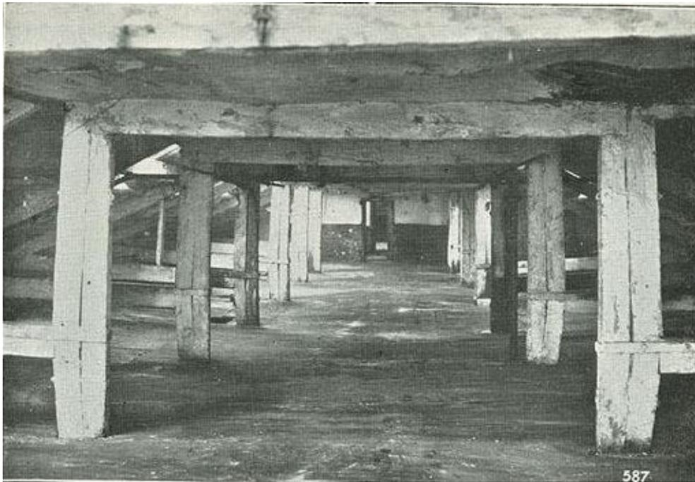
Figura 147. "Típico" ático de un "mill" de finales del siglo XVIII. Las cerchas de madera son de tipo "queen", esto es, de configuración tal que permite un espacio libre central para un uso específico (en muchas ocasiones, concretamente en Inglaterra, servía de escuela para los niños que trabajaban en las plantas inferiores) (Hill, 1927).
