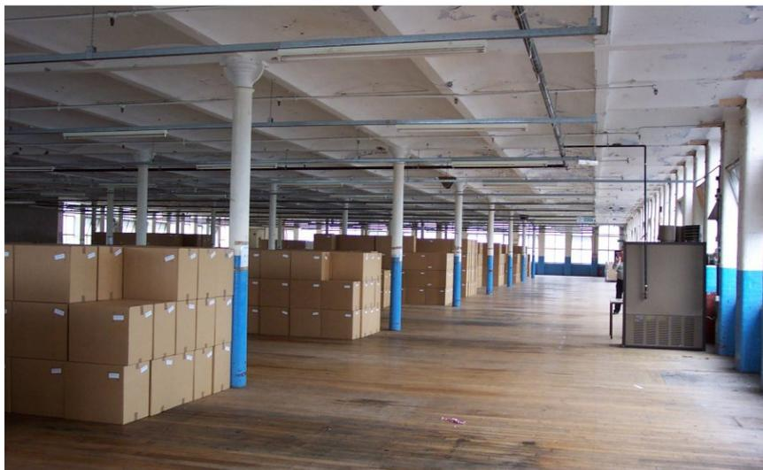
Figura 81. Belper East Mill, 1912. Esta foto da cierta idea de la escala de estos edificios a principios del siglo XX. Importante reseñar su estructura de acero, su fachada y ante todo, su diafanidad (University of the West of England. Department of Architecture and the Built Environment. [http://www.uwe.port.ac.uk/commercial/vic\\_mills/index.htm](http://www.uwe.port.ac.uk/commercial/vic_mills/index.htm)).
