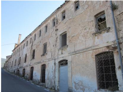
Figura 231. Molino Nuevo de Brutinel, en las inmediaciones del Molino Viejo. El aumento del número de ventanas en la planta superior, y debido a su proceso productivo, no tiene su origen en la necesidad de mayor iluminación, sino de ventilación, para el secado de las de papel. De ahí su nombre en valenciano hablado "ventanes" (Fotografía propia. Julio 2012).
