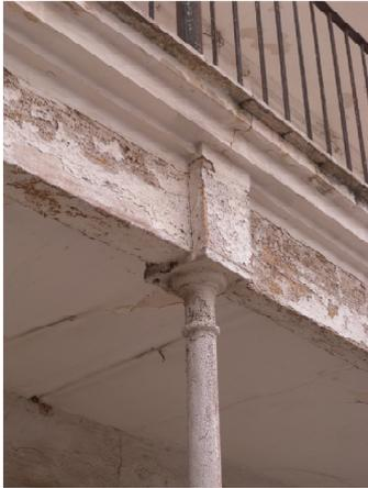
Figura 314. Patio interior. Detalle del apoyo de la viga de madera sobre un pilar de fundición macizo con capitel.
