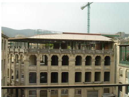
*Figura 264. Fábrica de Carbonell: grandes espacios huecos en fachada revestida de piedra artificial, con el remate en las ventanas de la última planta.*
