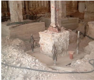
*Figura 251. Fábrica de Ferrándiz, detalle del apoyo del pilar sobre la zapata en planta baja, donde se aprecia su esbeltez al tratarse de un pilar metálico.*
