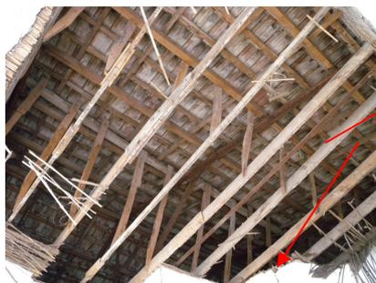
Figura 311. Cubierta a dos aguas correspondiente al edificio señalado. Las cerchas son metálicas. El entramado de madera es la estructura de sujeción del falso techo.
