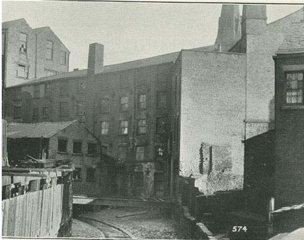
*Figura 146. Un "mill" construido en 1782, en Bolton, Gran Mánchester. Este un caso típico de manufactura con estructura completamente en madera, y cuya cubierta estaba realizada con cerchas también del mismo material (Hill, 1927).*
