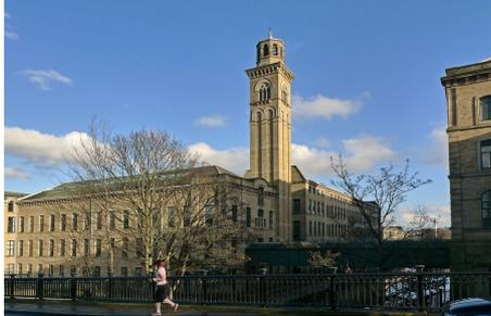
*Figura 139. New Mill de Saltaire, Bradford. La torre identifica la división del edificio en dos cuerpos, que coincidía con sendos accionamientos que aumentaban el rendimiento mecánico.*
