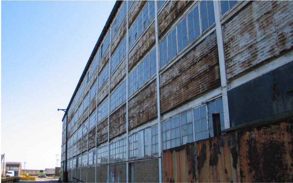
Figura 97. Astillero de Sheerness. Fachada lateral, con sus ventanales dispuestos de forma corrida en toda su longitud. Su carácter actual no se corresponde con sus más de 150 años de antigüedad (<http://www.built.org.uk/photographs/south-east.html>).
