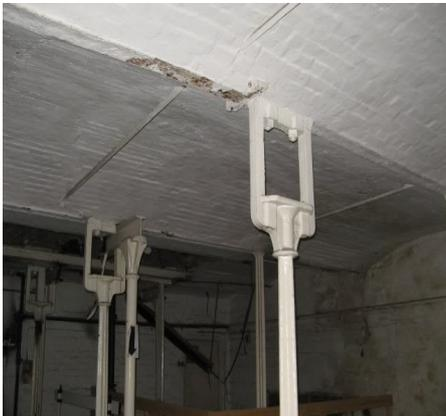
*Figura 59. Vista interior con sus vigas de fundición, con el detalle de la cabeza de las columnas del primer piso para alojar los ejes de transmisión
