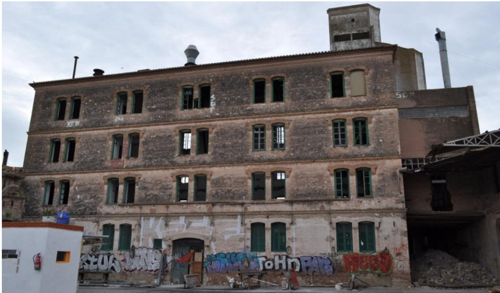
Figura 291. Fachada desde el patio interior. Se aprecia la consistencia de los muros portantes, y la disposición repetida de las ventanas, sistema constructivo típico encontrado en los "mills" ingleses del siglo anterior.
