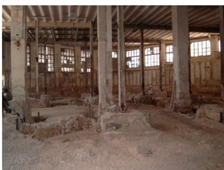
Figura 252. Fábrica de Ferrándiz, vista del forjado con bovedillas apoyando en viguetas metálicas, que a su vez descansan sobre vigas de acero de alma llena roblonada. También se ven los pilares de acero mediante perfiles roblonados, cuya distancia es de 5 m.
