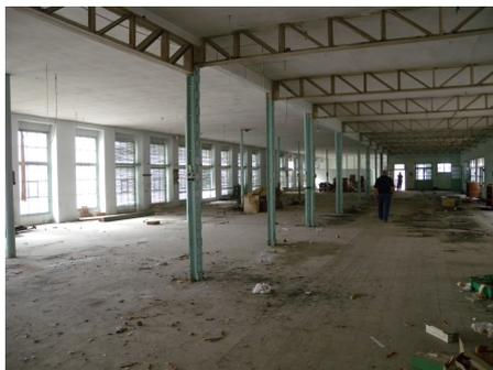
Figura 320. Diafanidad e iluminación, con todavía muros de carga. Columnas empresilladas con roblones.
