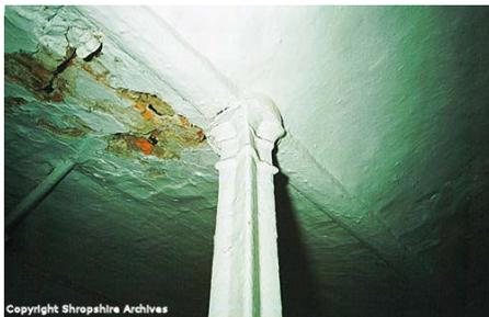
Figura 181. Ditherington Mill. Pilar de sección maciza cruciforme (Shropshire Archives).
