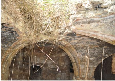
Figura 236. Molino en el Río Molinar. Bóvedas con rasilla (no de canto) y pilares cruciformes de ladrillo macizo (Fotografía propia. Julio 2012).
