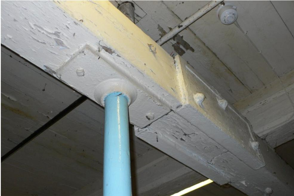
*Figura 172. Masson Mill, 1783, sobre el río Derwent. Se trata de uno de los primeros molinos de Arkwright, que en este estudio destaca por su temprana utilización del hierro fundido para el apoyo intermedio de la viga de madera, continua precisamente en ese punto, a modo de junta a medio madera<sup>252</sup> (University of the West of England. Dep. Architecture, 2014).*
