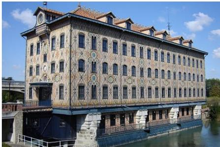
Figura 7. Fábrica de chocolates Menier, en Noisel-sur-Marne (Francia). El edificio apoya sobre 4 pilares, entre los que se instalaron 4 turbinas hidráulicas para la producción de energía mecánica por la fuerza del río. ([http://en.wikipedia.org/wiki/Menier\\_Chocolate](http://en.wikipedia.org/wiki/Menier_Chocolate)).
