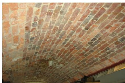
*Figura 230. Forjado de la planta baja del North Mill, Belper (Inglaterra), 1804, con bóveda de cañón en ladrillo y pilares de piedra (propia).*
