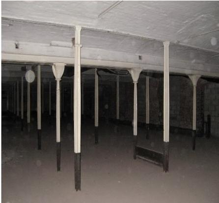
*Figura 58. Vista interior con sus vigas y soportes de fundición.
