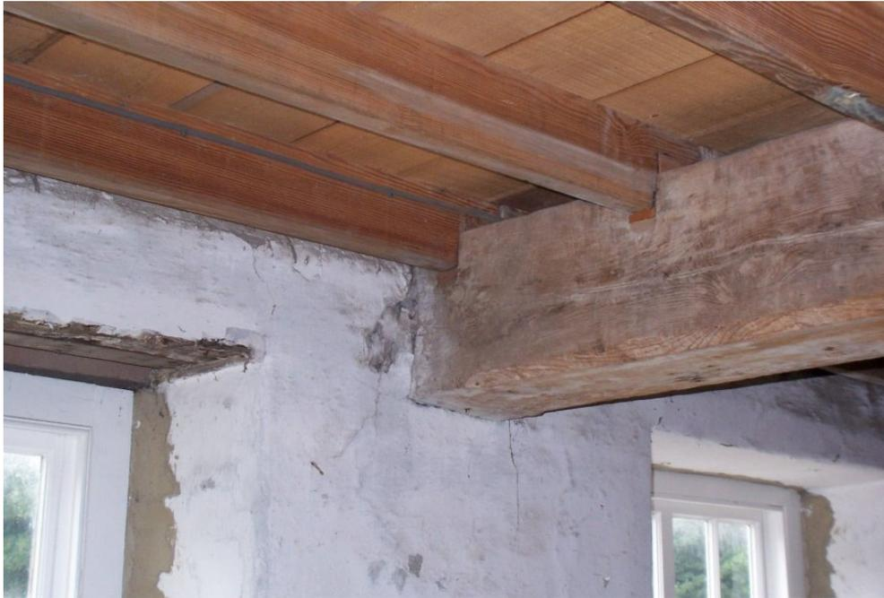
*Figura 145. Cromford Mill, primero de los edificios de Arkwright, de 1776: entablado de madera para la formación de los pisos, con viguetas y vigas de madera apoyando en los muros perimetrales (University of the West of England. Dep. Architecture, 2014).*
