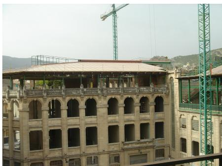
Figura 250. Fábrica de Ferrándiz, fachada con grandes ventanales gracias la altura entre forjados y los machones que soportan las vigas de los forjados.
