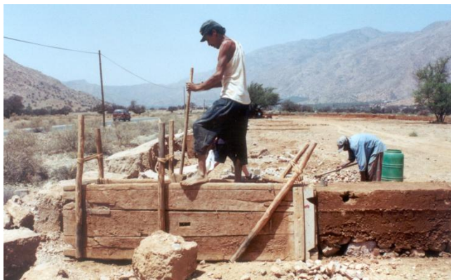
Figura 4.15. Construcción de tapia de primera hilada en el Valle del Draa (Marruecos). Véase el apisonado con pisón de mano de la cara superior de la tapia y el giro de los costales
