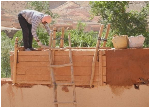
Figura 4.16. Construcción de tapia en el Valle del Mgoun, Alto Atlas (Marruecos). Véase el tapado de los huecos de las agujas y el apisonado con pisón de mano de la cara superior de la tapia
