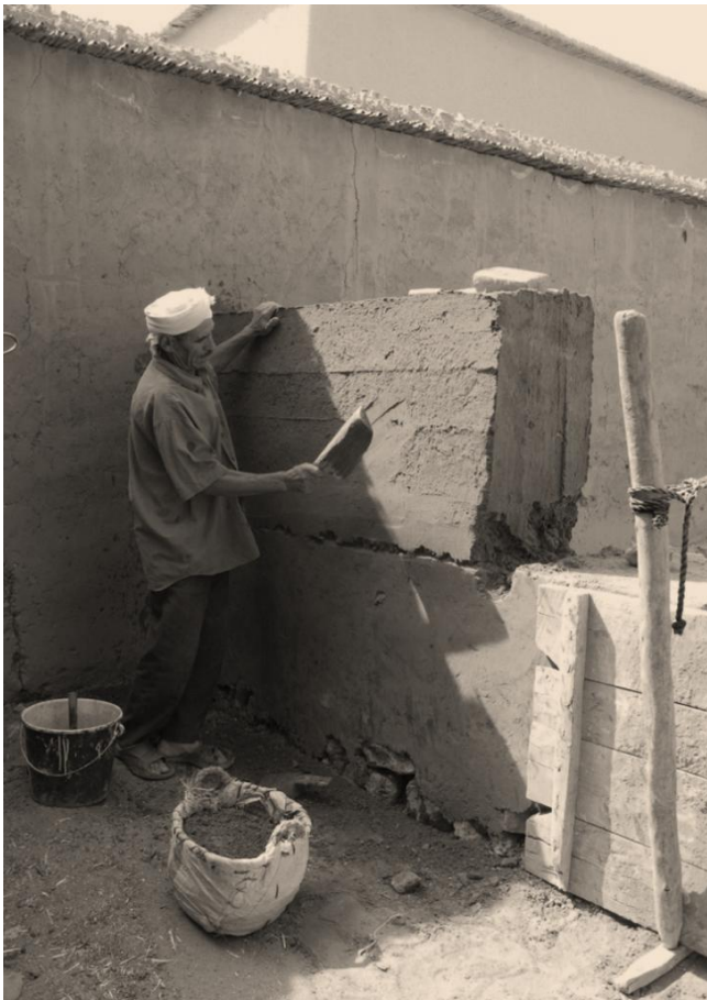
Figura 4.55. Construcción de tapia en el Valle del Mgoun, Alto Atlas (Marruecos). Véase la primera operación del takbhat, consistente en el maceado del paramento con pisón manual
