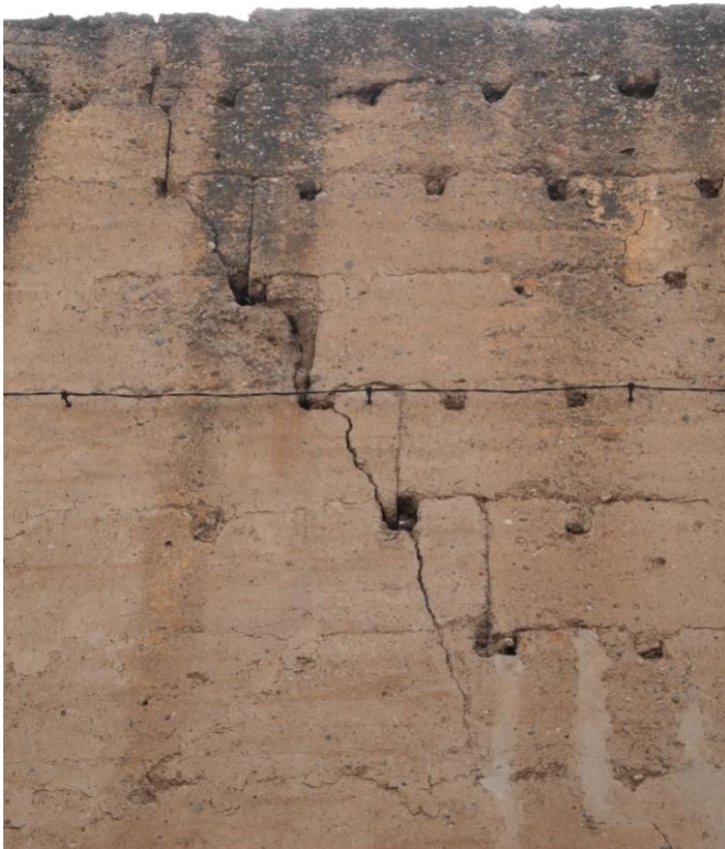
Figura 4.17. Muros de tapia en el Palacio El Badi de Marrakech (Marruecos). Véase los huecos horizontales en la posición de las agujas recuperables (a) y la junta de tajo de trabajo (b)
