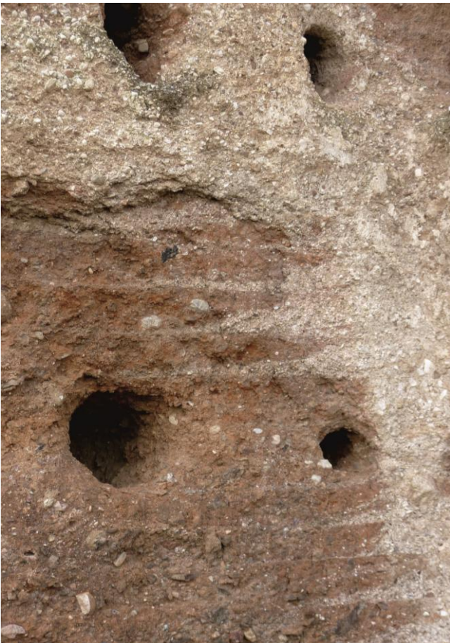
Figura 4.7. Detalle de tapia calicostrada en el Castillo de la Peza (Granada) (a) y muralla nazarí del Albaicín (b)
