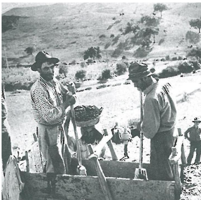
Figura 4.10. Construcción de tapias en Portugal (1955) Fuente: Ordem dos Arquitectos IARP/OAPIX
