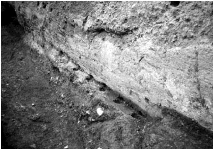
Figura 4.20. Impronta de las oquedades de las puntas de los costales en la zarpa de cimentación. Fuente: a-b) S. Ruiz Torres 1998 c) M. Martín García 1998
