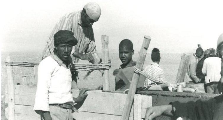
Figura 4.11. Construcción de tapia en el aeropuerto de Ouarzazate (Marruecos) Fuente: J. Labiche 1974
