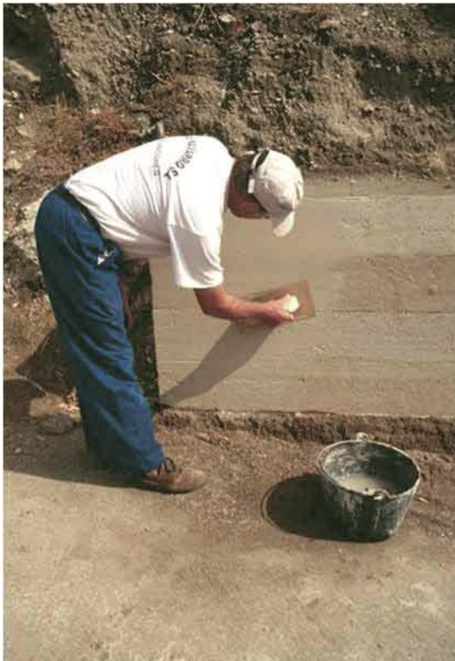
Figura 4.5. Proceso de enlucido y alisado superficial de la costra en tapia calicostrada
