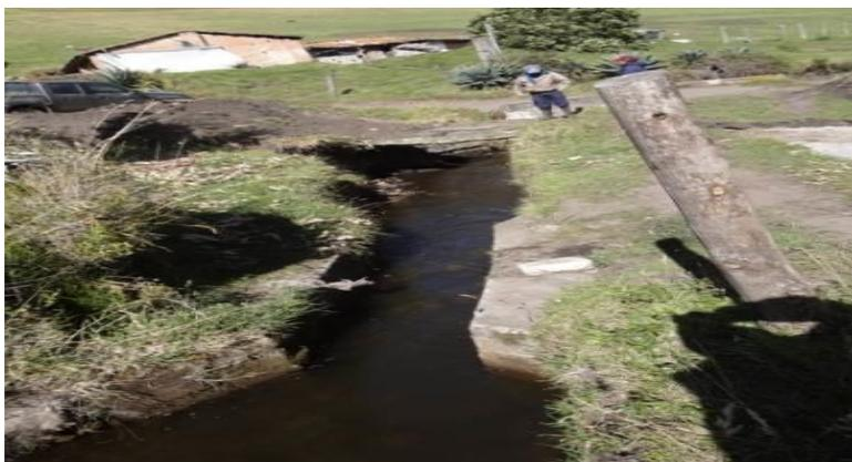
Ilustración 3: Situación actual de la conducción (canal a cielo abierto)
