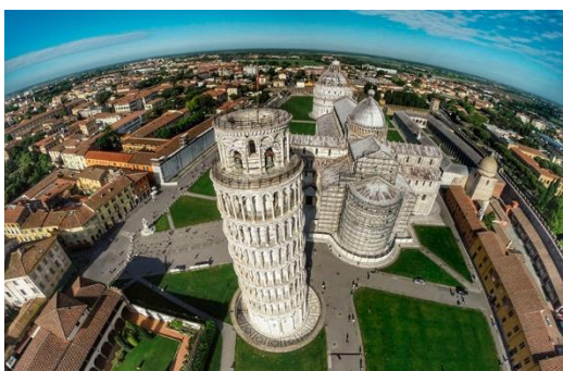
Fig. 14: Imagen aérea de la torre de Pisa
