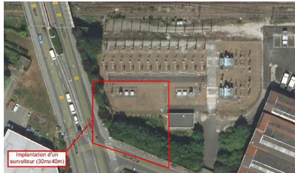
Figure 150 : Sous-station de Noisy-le-Sec Source : SNCF
