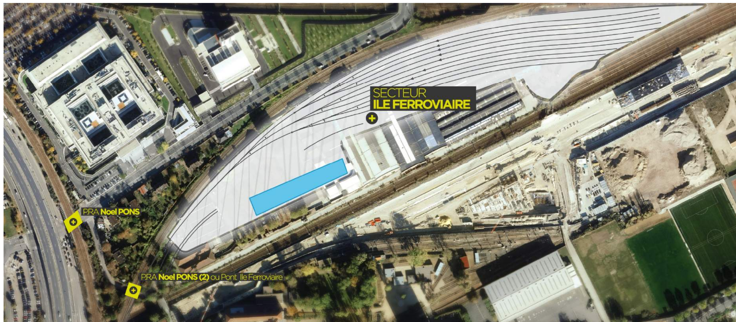
Figure 105 : Vue d'ensemble du secteur Ile ferroviaire au nord du site de Nanterre La Folie Source : SYSTRA
