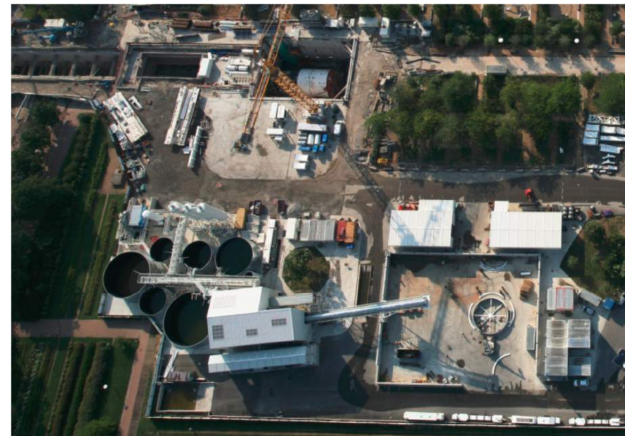
Figure 37 : Vue aérienne de la base chantier du tunnelier pour le prolongement de la ligne B du métro de Lyon à Oullins Source : SED
