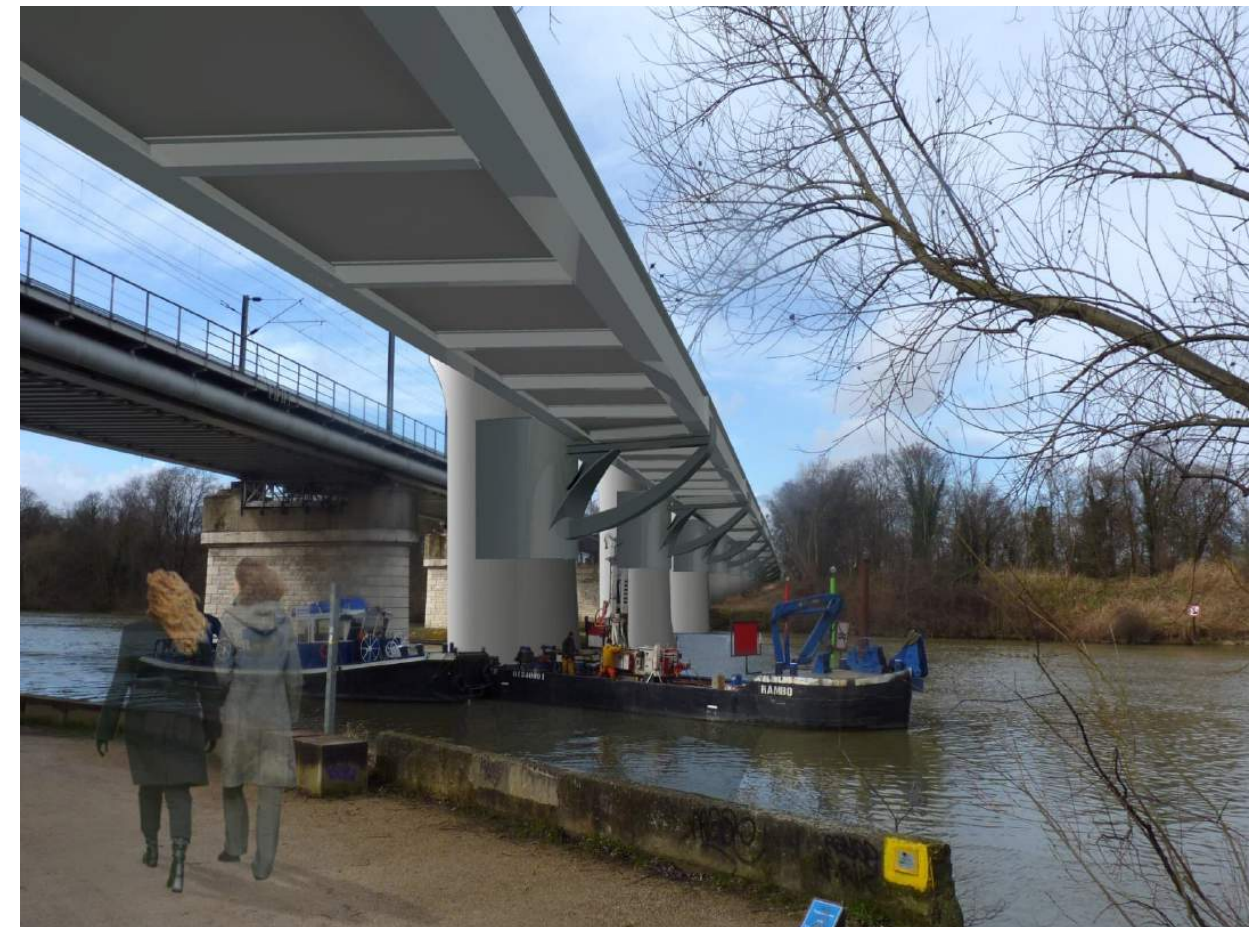
Figure 127 : Vue sur la liaison douce depuis la berge en rive gauche Source : SNCF Réseau
