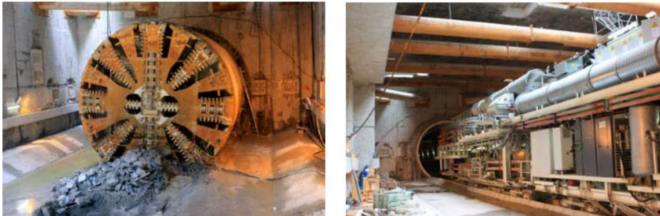
Figure 35 : Ripage du tunnelier en gare Source : Site du prolongement de la ligne de métro 12
