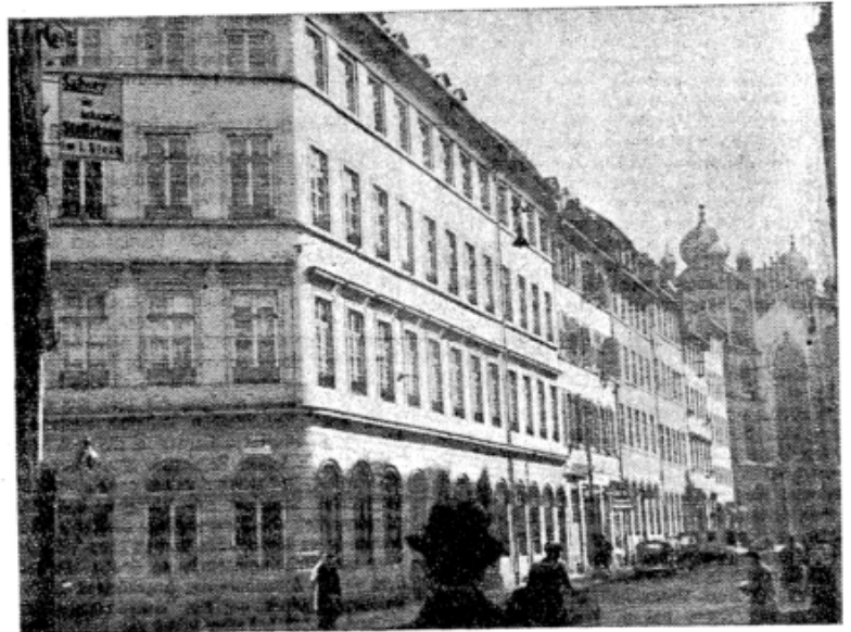
Das Frankfurter Gemeindehaus, das ehemalige Bankhaus der Rothschilds
