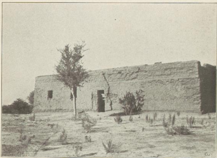
Wohnhaus des Herero-Kapitäns Michael bei Omaruru, Schauplatz des heftigsten Kampfes am 4. Februar 1904.
