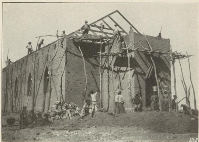
Missionskirche der Okombaher Bergdamara im Bau.
