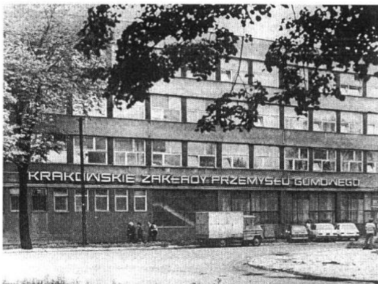
Fot. 18. Krakowskie Zakłady Przemysłu Gumowego „Stomil” – budynek biurowy
