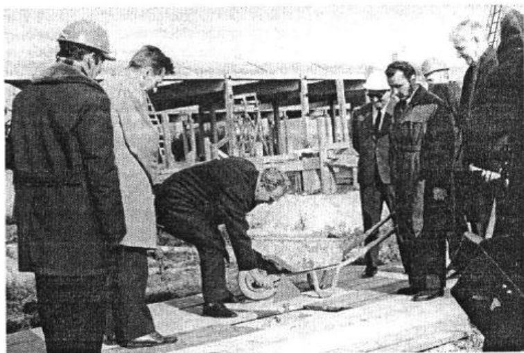
Fot. 46. Wmurowanie kamienia węglanego pod nowy budynek w Piastowie
