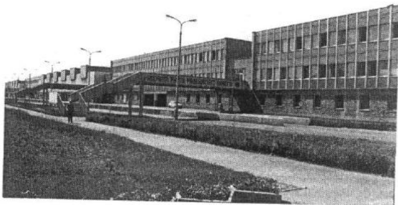
Fot. 30. Nowe obiekty zbudowane za Sanem
