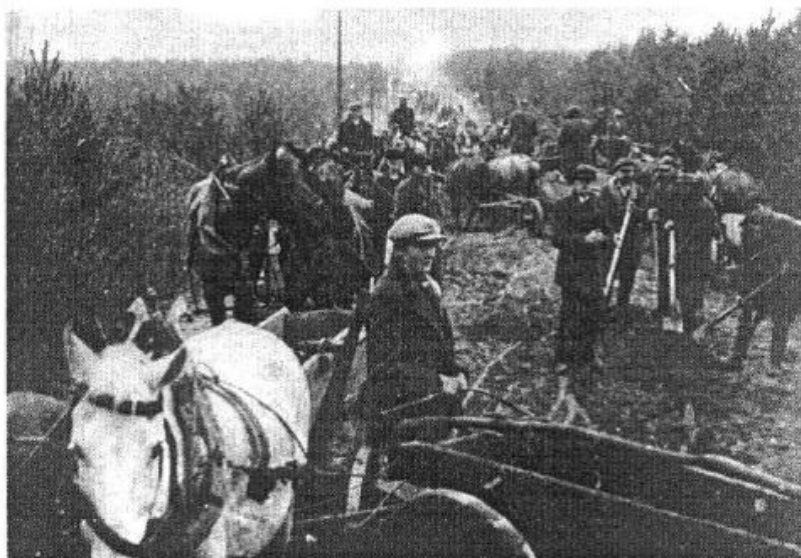
Fot. 1. Budowa głównej drogi dojazdowej do Fabryki Gum Jezdnych w Dębicy (1938 r.)
