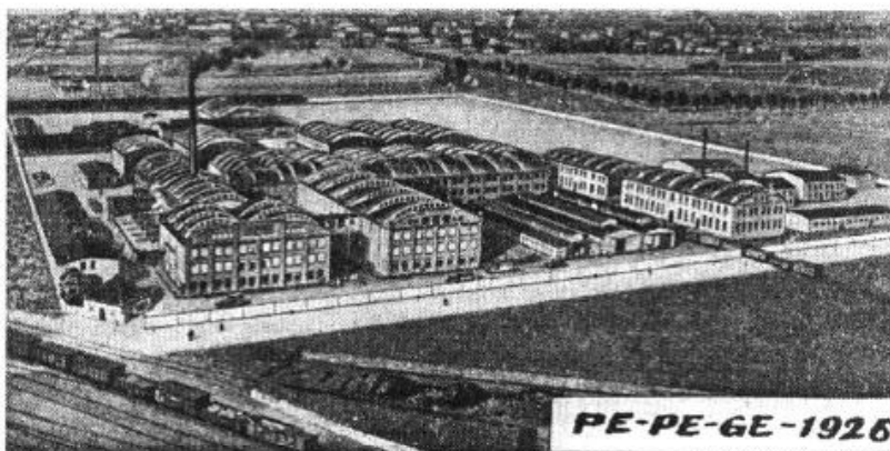
Fot. 4. Widok ogólny fabryki PE-PE-GE (1926 r.)
