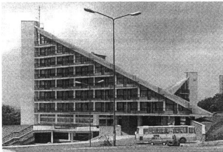
Fot. 13. Dom leczniczo-rehabilitacyjny „Muflon” DZOS w Ustroniu
