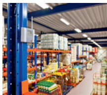
Überwachung des Lebensmittel-lagers
