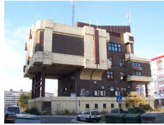
Abb. 348: Ein modernes Gebäude in Belgrad (Španskih boraca 22).
