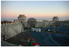
Abb. 402: Istanbul: Yedikule als Teil der Stadtmauer (4. Jahrhundert).
