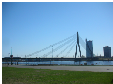
Abb. 213: Die Vanšu-Brücke von Riga.
