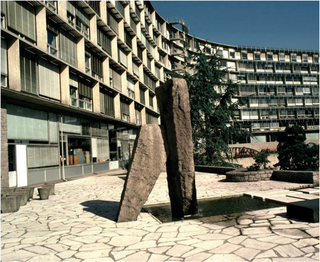
► Siège de l'UNESCO, extérieur du bâtiment Fontenoy, 1981
