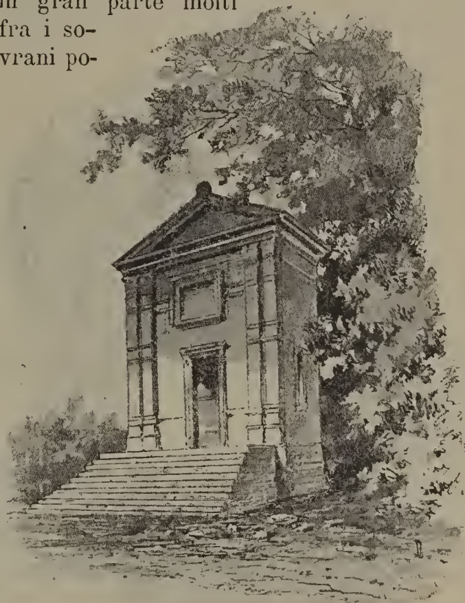
Santuario fuori il piazzale di Montevergine.
