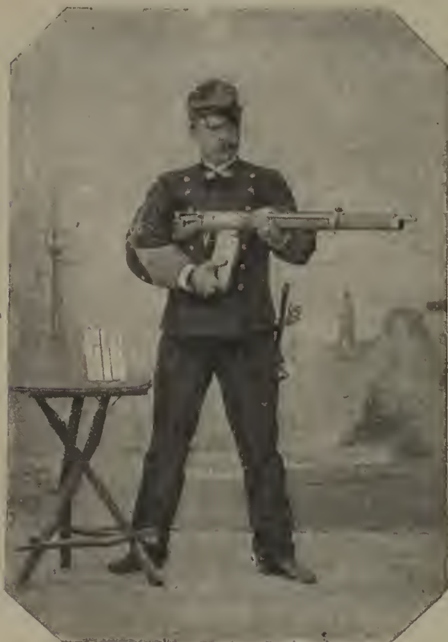
Fucile mitragliera a gas. Caricamento con serbatoio anovibile.
