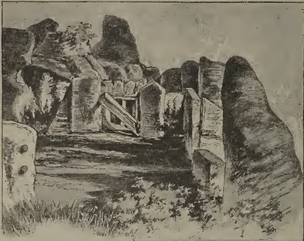
Avanzo della torre de' Giganti di Gozo.
