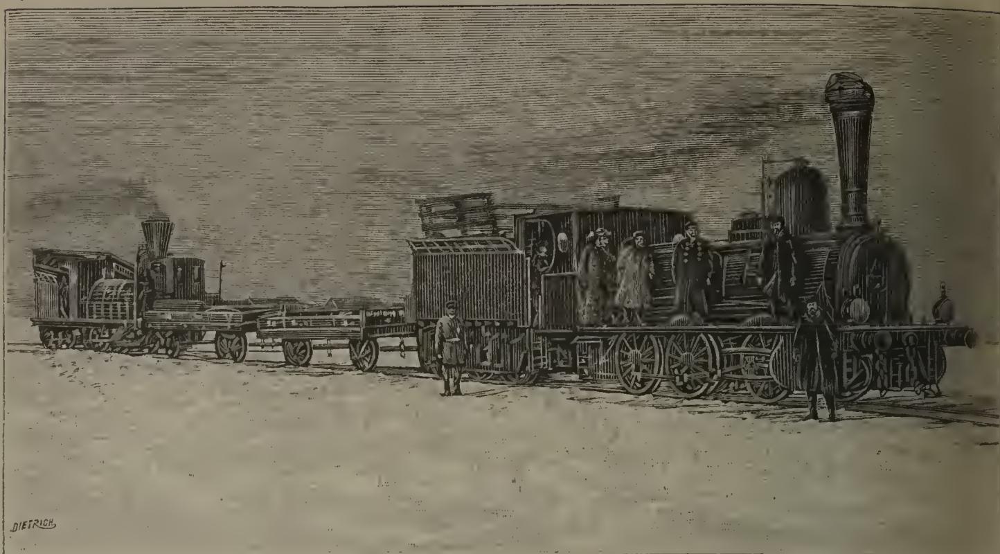
Treno carico di materiali.
