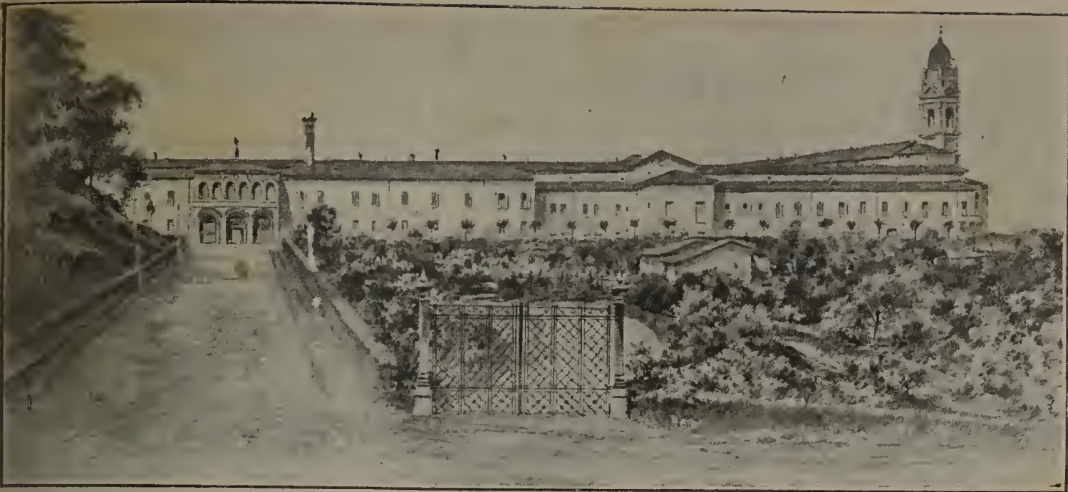
Bologna. — Istituto ortopedico Rizzoli. (Facciata principale ed ingresso).
