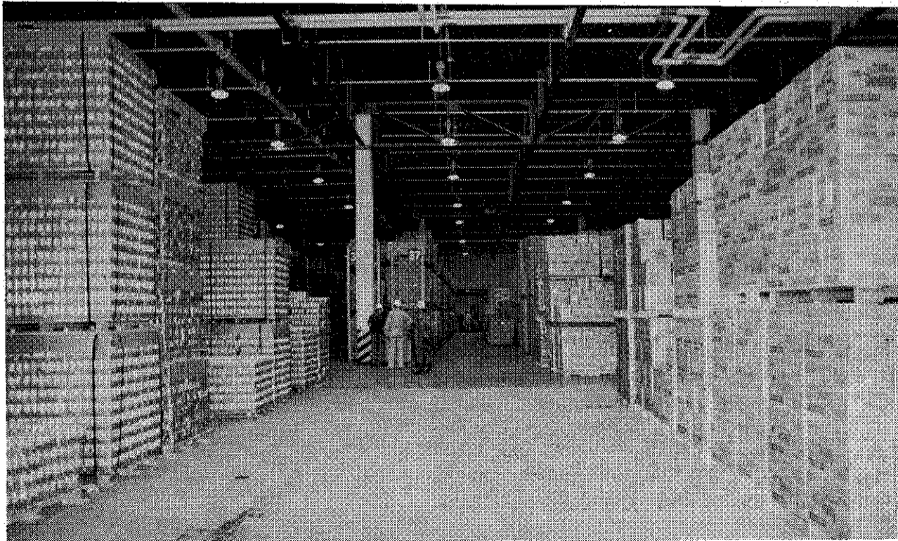
새로 신축 중인 용산카미서리의 공사중 일부 완성된 창고의 내부모습.
