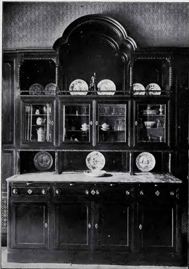
K. P. C. DE BAZEL, Architect : Gedeelte van een eetkamerbetimmering, uitgevoerd in mahonie- en ebbenhout door de werkplaatsen " De PLOEG " Amsterdam, 1906.
