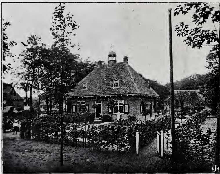
K. P. C. DE BAZEL, Architect : Kantoorgebouwtje " Oud-Bussem „.
