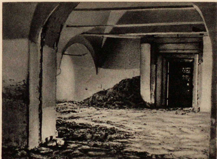
Третья Покровская церковь в г. Боровске Московской области, оскверненная немцами
