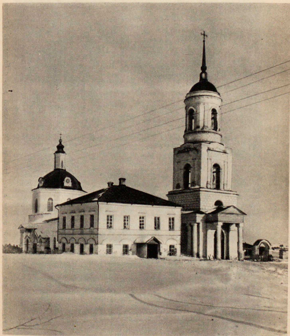
Покровская церковь с. Адышево Оричевского района Кировской области
