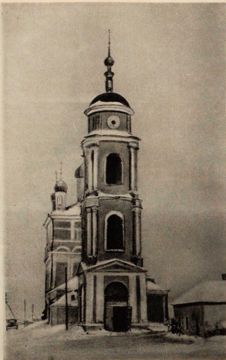
Третья Покровская церковь в г. Боровске Московской области, оскверненная немцами
