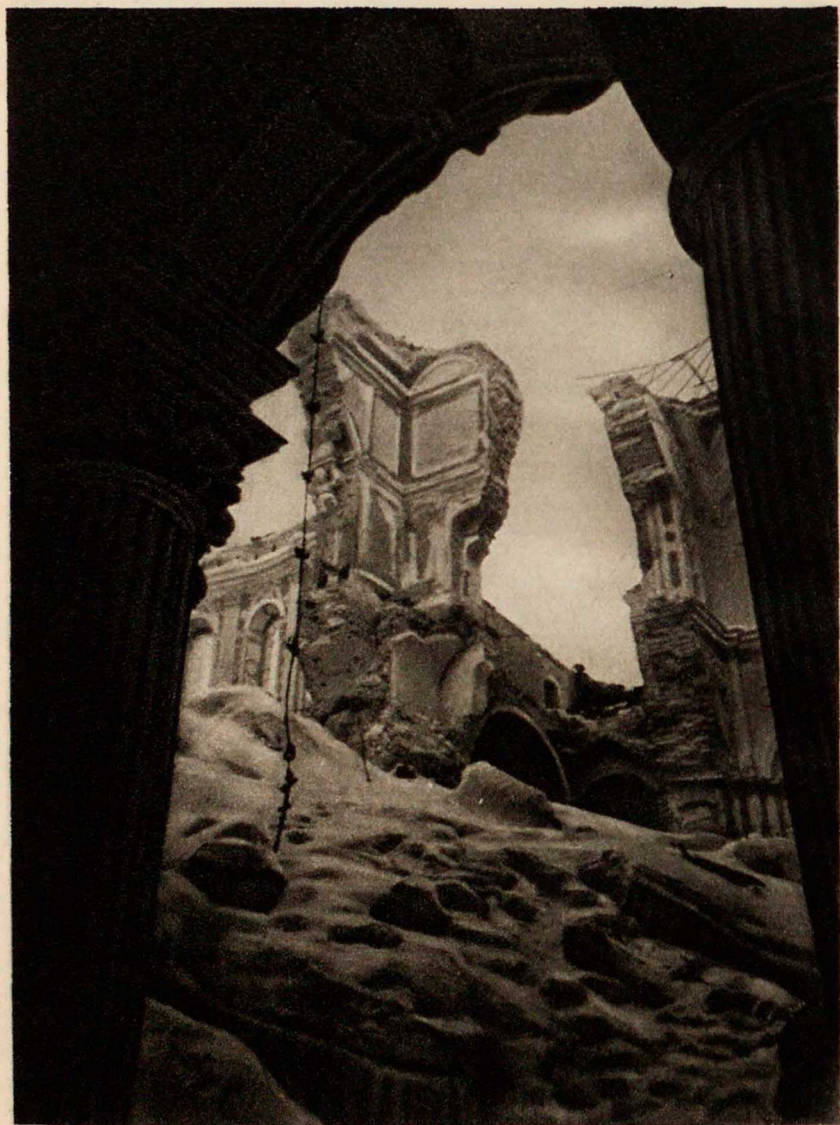
Разрушения в Новом Иерусалиме
