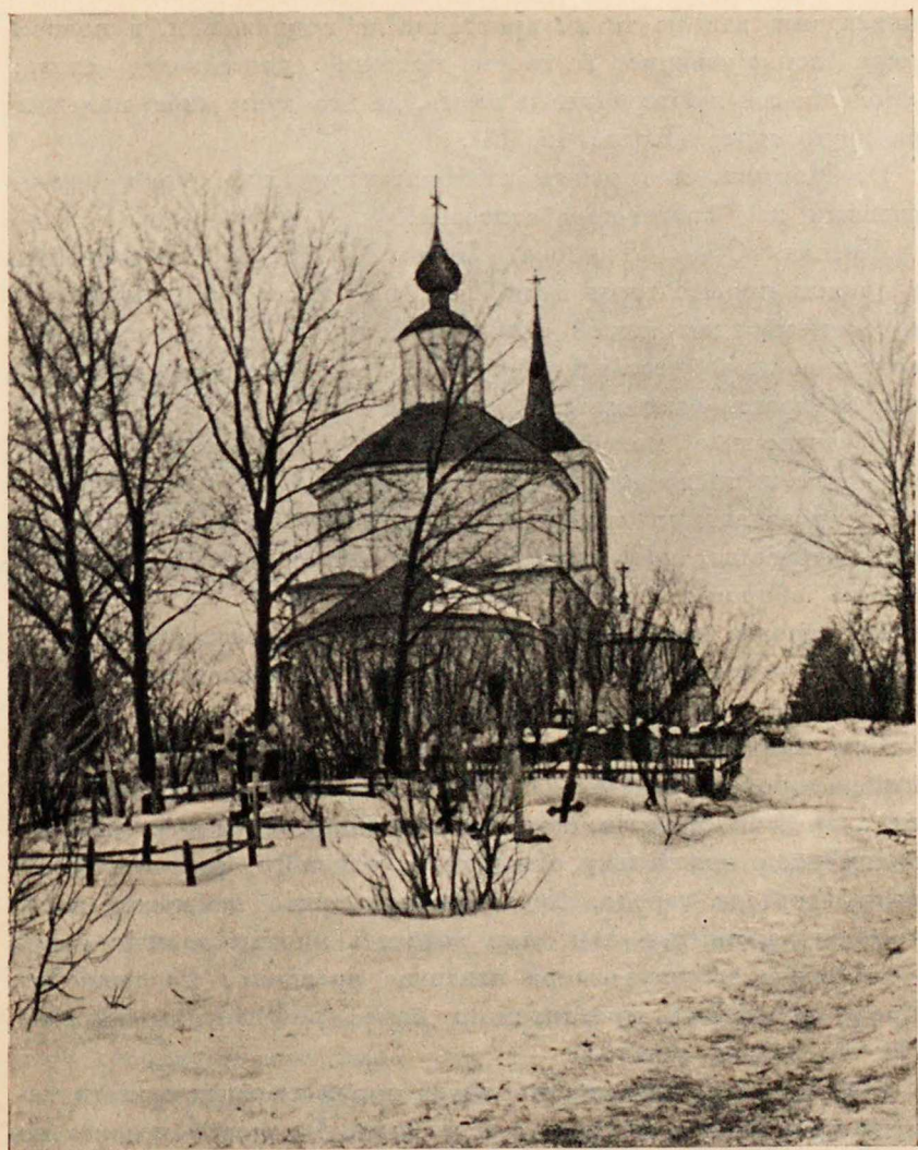
Церковь в селе Корижа Малоярославецкого района Московской области
