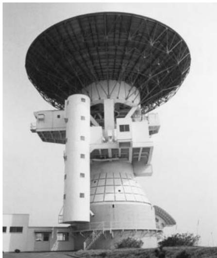
写真-2 竣工時の雄姿(写真提供:通総研)。円筒状の階段室は、アンテナと一緒に方位角軸周りに動いた。
