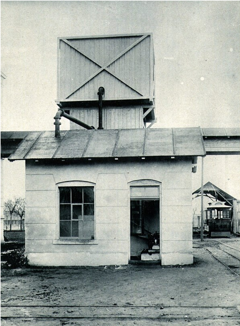
Gradirwerk der Kraftstation in Niedersedlitz.
