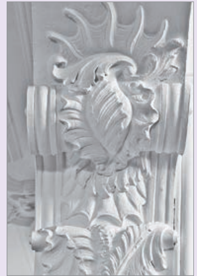
Stucwerkornament in de gang.
