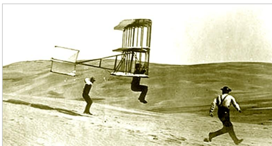
Máquina de alas oscilantes de Lamson construida por Chanute, con algunas modificaciones como la anulación del sistema de comando tipo Canard . Octubre de 1902
