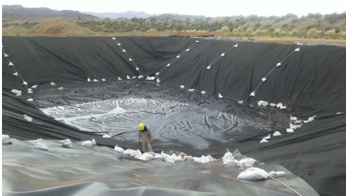
Plan de Remediación de Pasivos Ambientales Mineros en Abra Pampa, Jujuy. Impermeabilización de la celda, ubicada en Mina Aguilar, para depósito de escombros mineros y suelos afectados de la Remediación Minera de Abra Pampa
