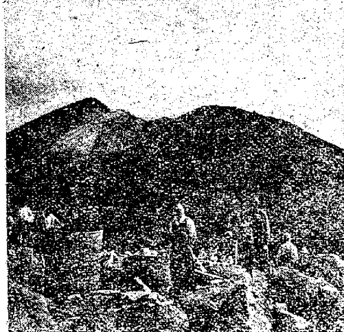
コロナ観測所の工事はじまる 8月上旬すでに基礎工事を終え、下旬にはドームの鉄骨が到着するはず。寫眞は工事場から乗鞍の主峰権現岳を仰いだところ。
