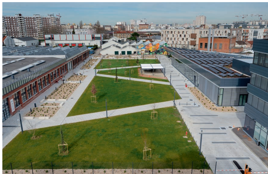
Saint-Ouen : Le site construit en 1928 comme siège social de Bosch-Lavalette est maintenant un campus moderne.
