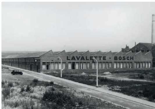
Vue du nouveau bâtiment de l'usine Bosch-Lavalette à Saint-Ouen, 1931
