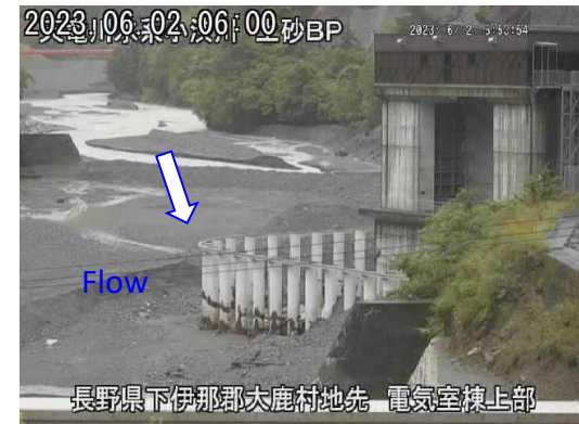
呑口部バイパス運用直後の状況 (6/2 6時頃 流入量約40m 3 /s)
