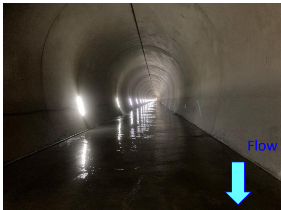
工事完成後の状況 (吐口から約1,000m)
