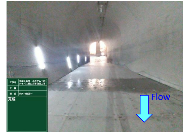
工事完成後の状況 (鋼製ライニング部)
