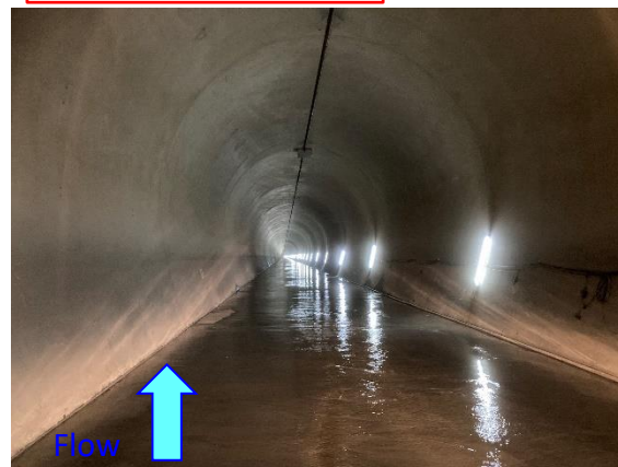
工事完成後の状況 (吐口から約2,000m)
