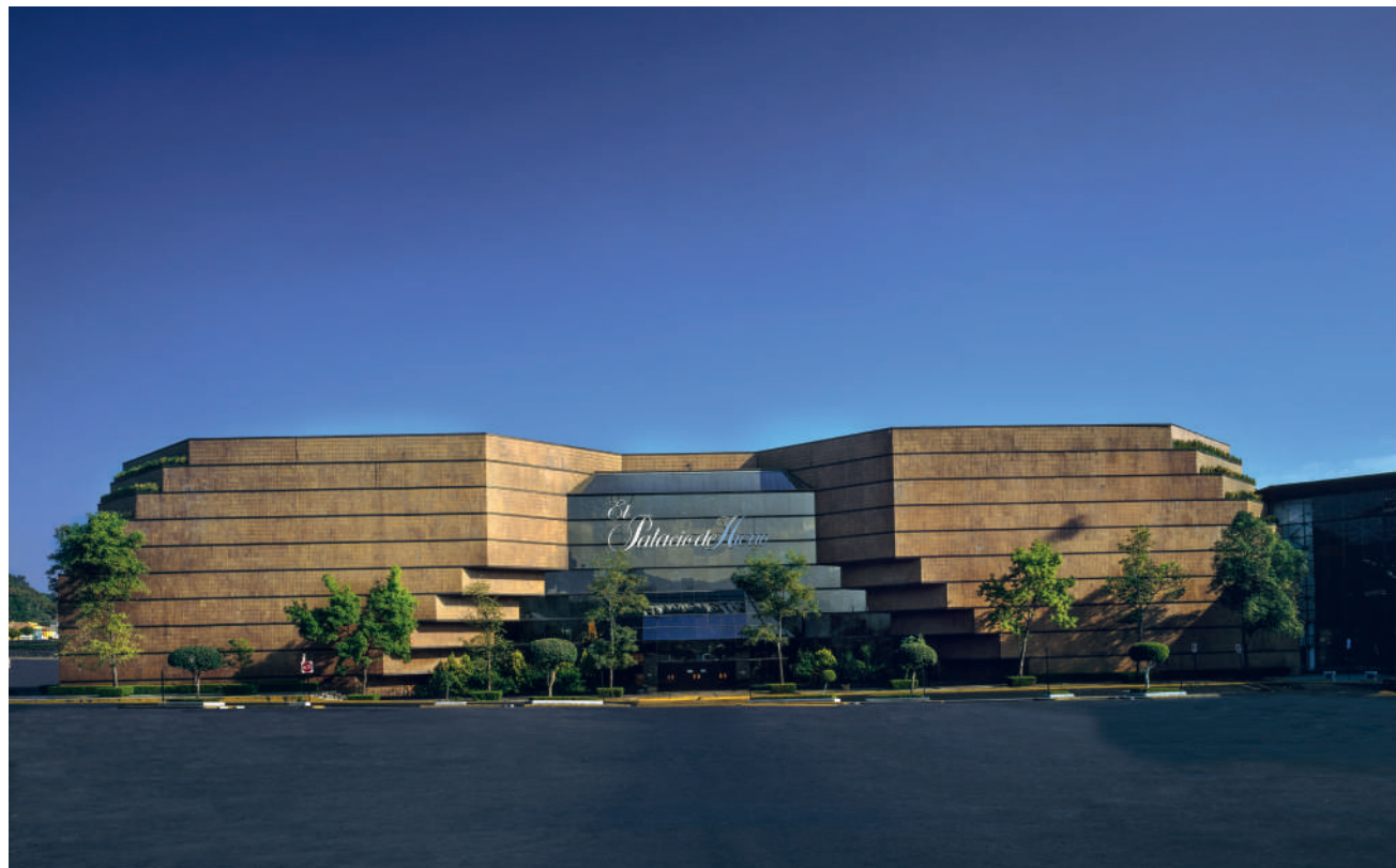
El Palacio de Hierro Perisur en sus inicios.
