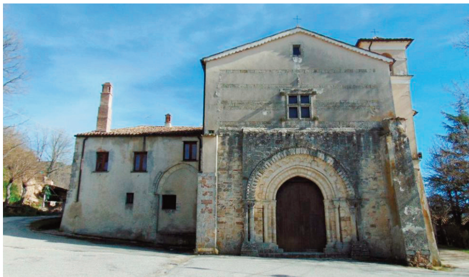
Abbazia cistercense di Santa Maria della Sambucina
