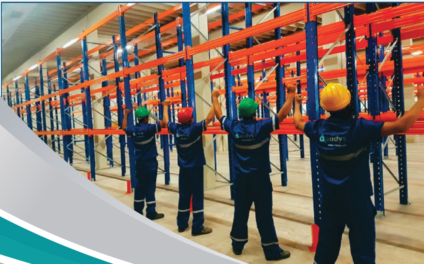
Instaladores de Rack
