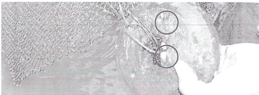
Foto 6: Detalhe da tela de proteção e peso de fixação da mesma ao fundo do canal, observar a presença do mexilhão-dourado (círculos vermelhos).
