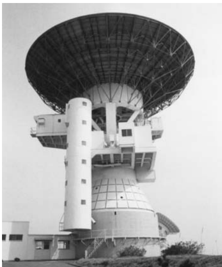
写真-2 竣工時の雄姿(写真提供:通総研)。円筒状の階段室は、アンテナと一緒に方位角軸周りに動いた。
