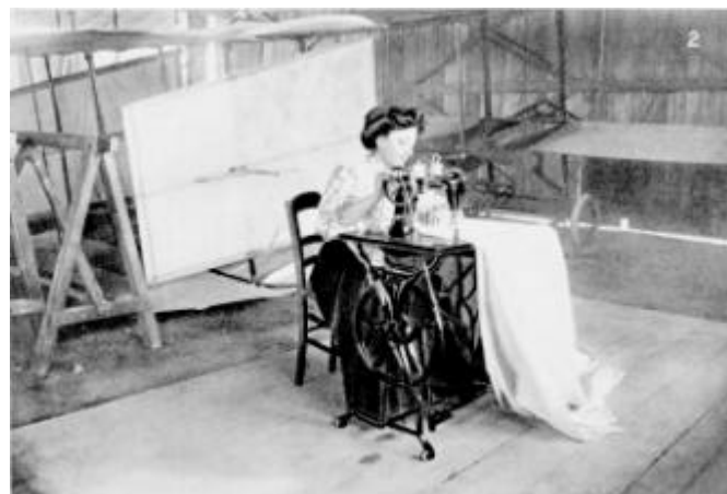
Réalisation d'un entoilage de HF-3 en 1909. (Archives municipales de Boulogne-Billancourt).
