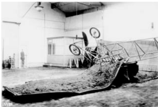
Test de structure des ailes chez Farman à Billancourt. Des sacs de sable sont déposés jusqu'à effondrement de l'aile. (Archives municipales de Boulogne-Billancourt).
