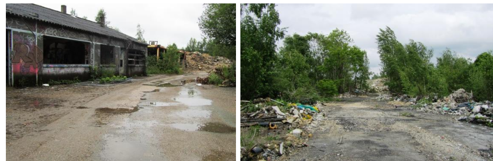
Figure 50. Photos de l'existant au droit du futur SMR
