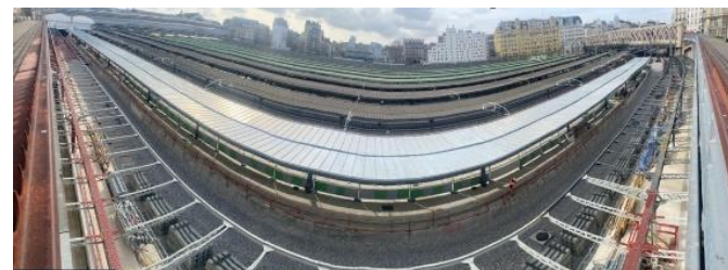
Zone AB Abris du quai 2 rénovés
