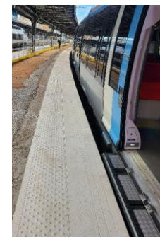
Demi-quai rehaussé et à niveau
