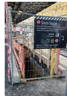
Rehaussement des escaliers
