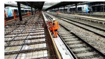
Rehaussement du quai 10 (Quai creux)
