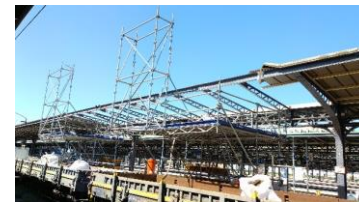
Remaniement des abris de quai
