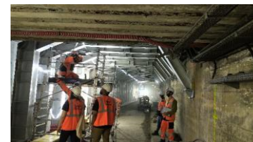
Renforcement de la galerie Sous Quai 10
