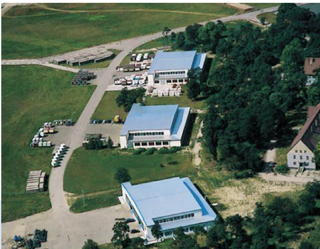
Industrie- und Gewerbegebiet Flugplatz Lönnewitz-Falkenberg
